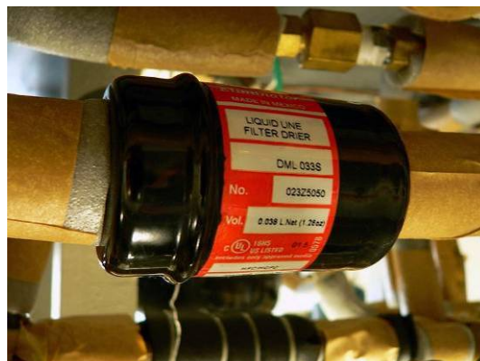
Figura 3.9 - Filtro secador
