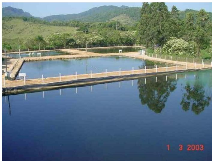
FIGURA 6: Sistema de lagoas de estabilização do aterro sanitário de Biguaçu.
