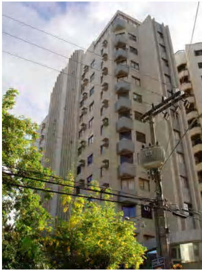
Fig. A4.61- Foto do edifício
