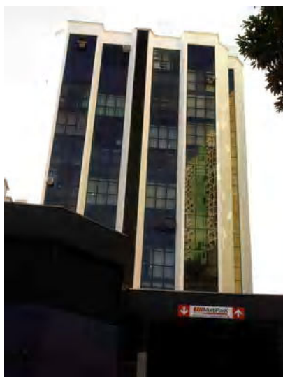
Fig. A4.23- Foto do edifício
