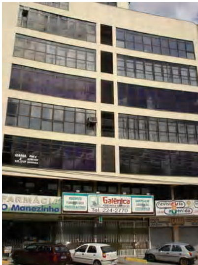
Fig. A4.13- Foto do edifício
