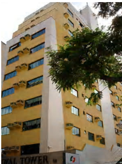
Fig. A4.59- Foto do edifício
