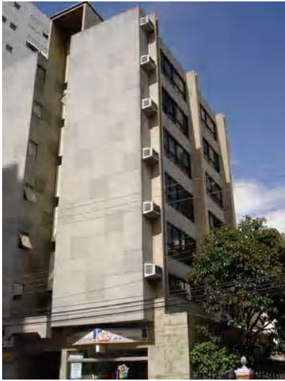
Fig. A4.1- Foto do edifício.
