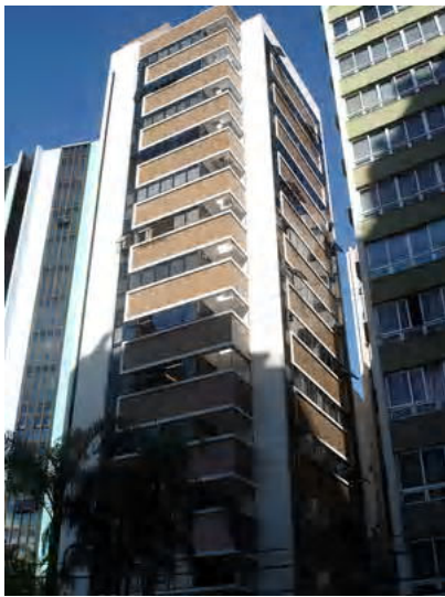
Fig. A4.33- Foto do edifício
