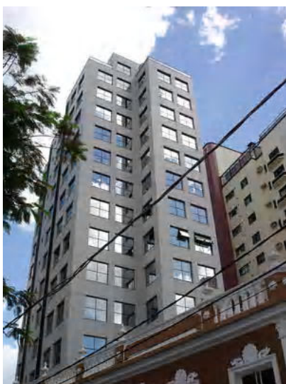
Fig. A4.49- Foto do edifício
