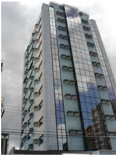
Fig. A4.57- Foto do edifício
