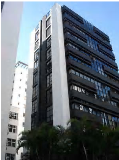
Fig. A4.43- Foto do edifício
