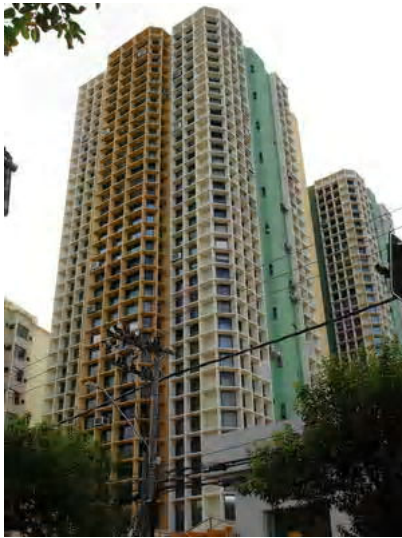
Fig. A4.29- Foto do edifício
