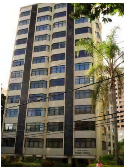
Fig. A4.55- Foto do edifício
