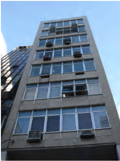
Fig. A4.68- Foto do edifício
