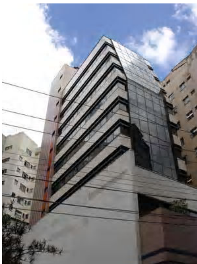
Fig. A4.45- Foto do edifício
