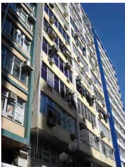
Fig. A4.11- Foto do edifício
