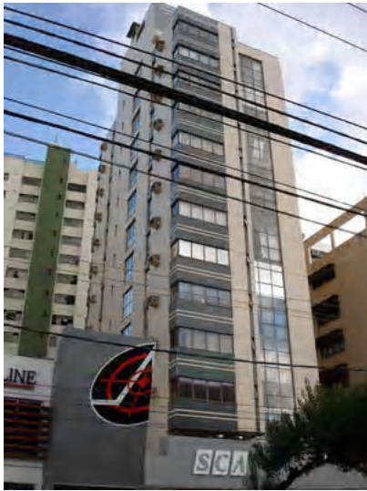
Fig. A4.53- Foto do edifício
