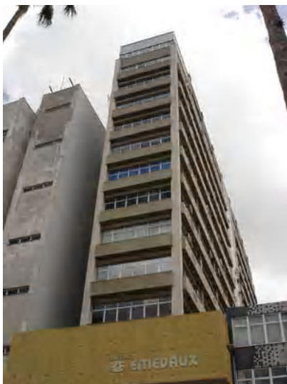
Fig. A4.37- Foto do edifício
