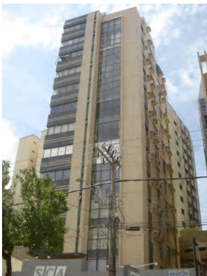
Fig. A4.3- Foto do edifício
