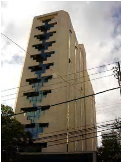
Fig. A4.17- Foto do edifício
