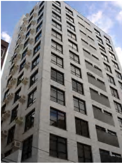
Fig. A4.31- Foto do edifício
