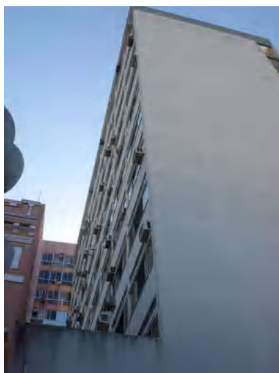
Fig. A4.9- Foto do edifício
