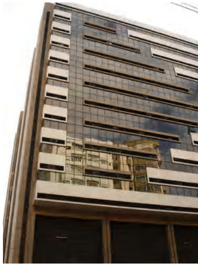
Fig. A4.25- Foto do edifício
