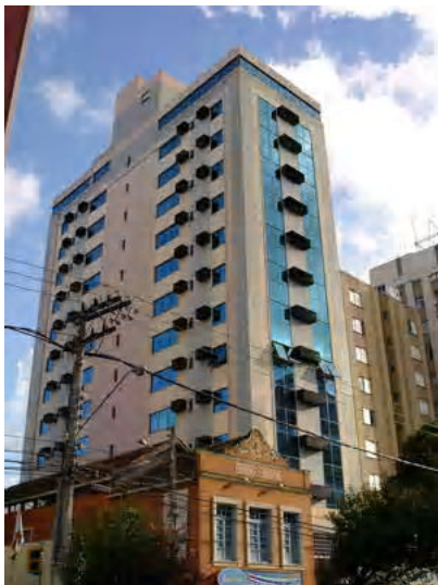
Fig. A4.47- Foto do edifício
