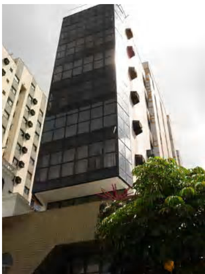
Fig. A4.51- Foto do edifício
