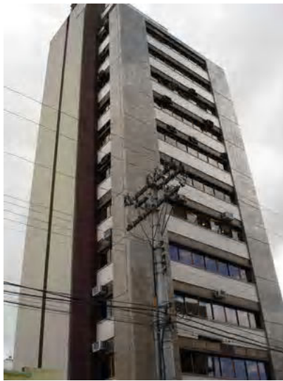
Fig. A4.27- Foto do edifício
