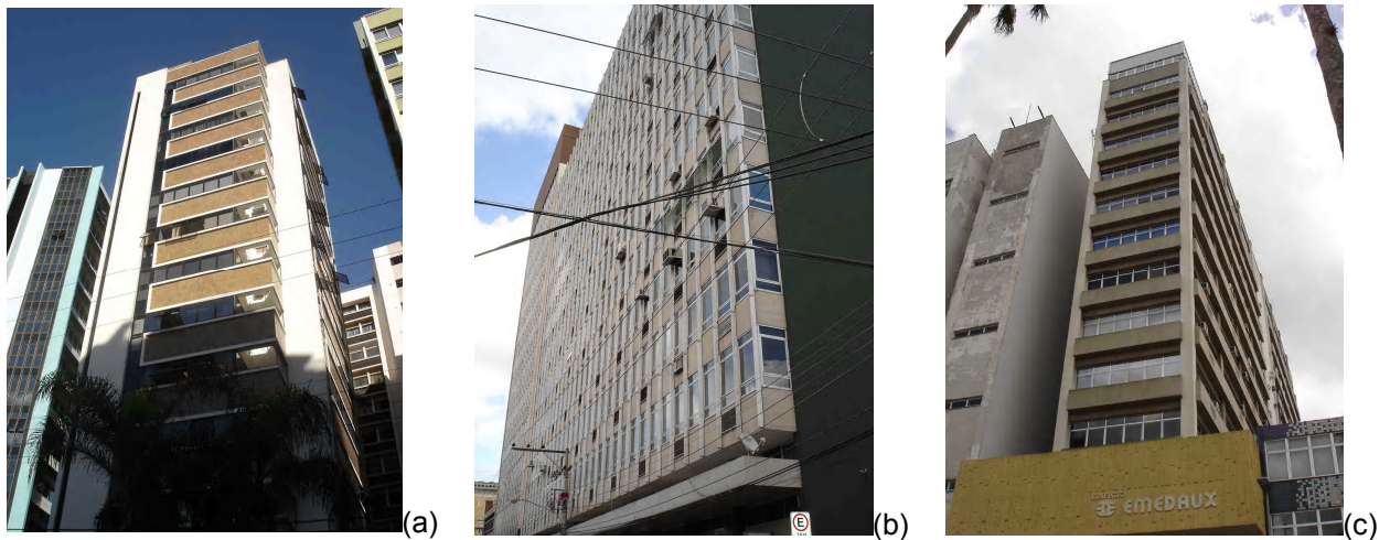
Fig. 4.23: Tipos de vidros com maior incidência: (a) Via Veneto – vidro fumê float 6mm, (b) Alpha Centuri – vidro comum 4mm e (c) Emedaux – vidro fumê.
