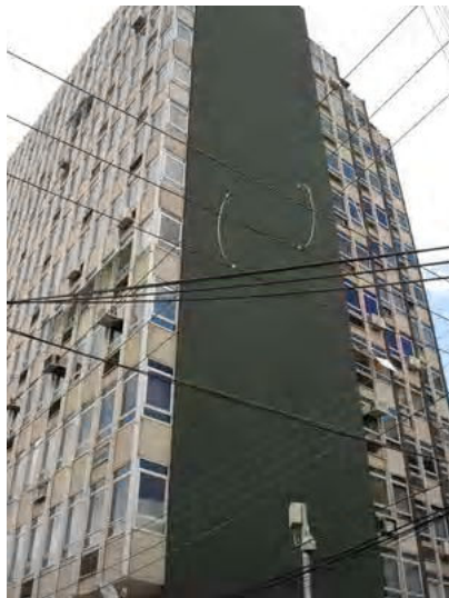
Fig. A4.7- Foto do edifício
