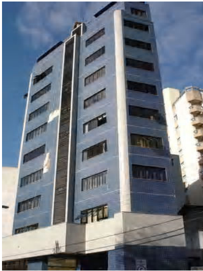
Fig. A4.15- Foto do edifício
