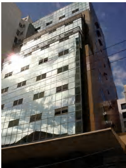
Fig. A4.66- Foto do edifício
