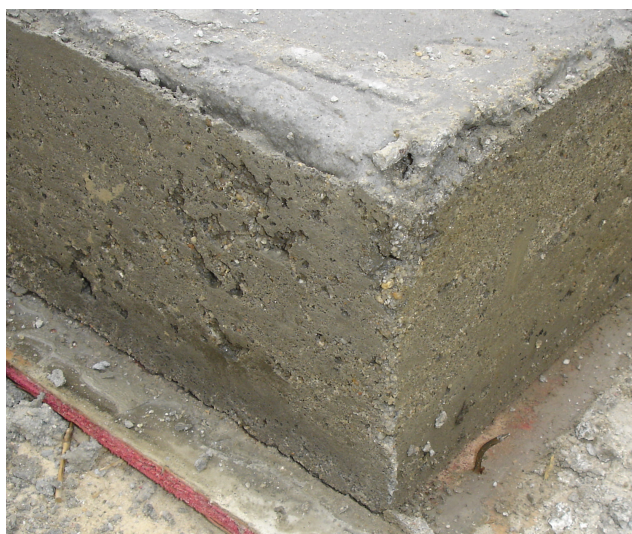
Figura 4. 44: desmolde do painel – canto.
