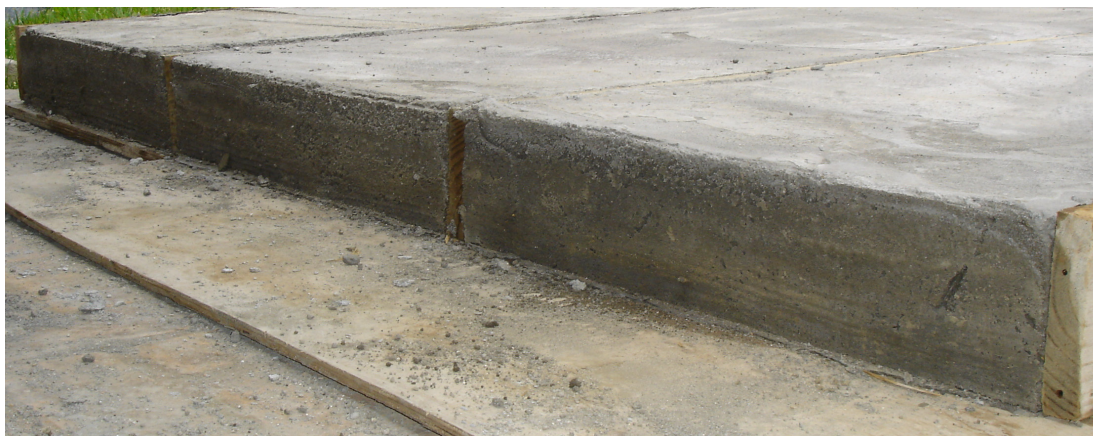
Figura 4. 43: desmolde do painel – remoção da lateral da forma de madeira.
