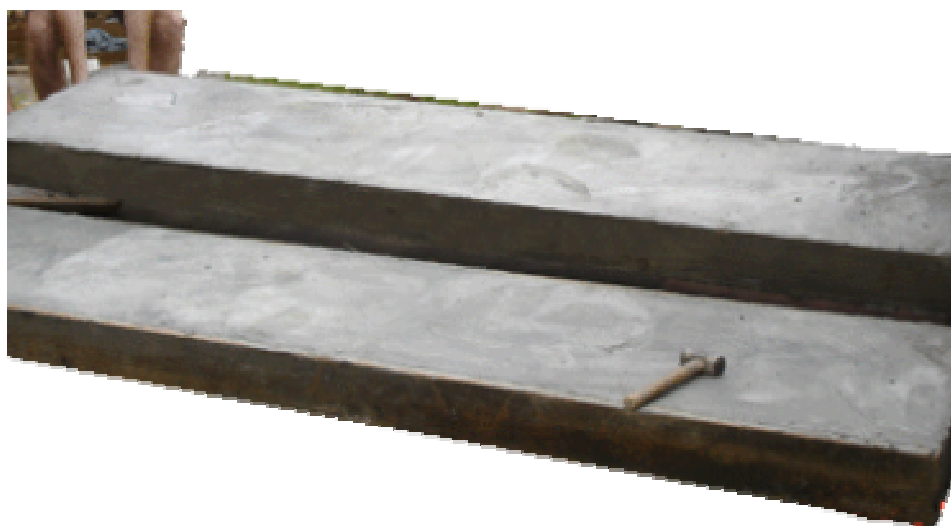
Figura 4. 45: desmolde do painel.
