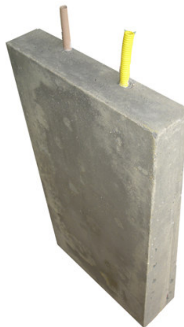
Figura 4. 11: painel com esperas da tubulação e do eletroduto. Fonte: Brasiltec (2005)
