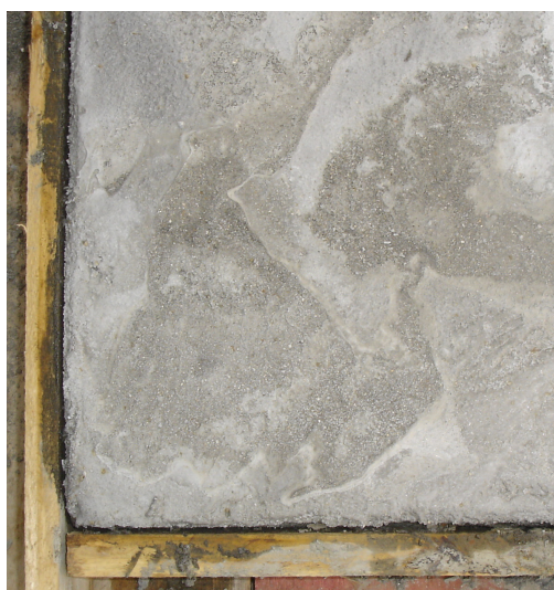
Figura 4. 41: desmolde do painel – painel solto da forma devido ao uso de desmoldante antes da fabricação dos painéis.
