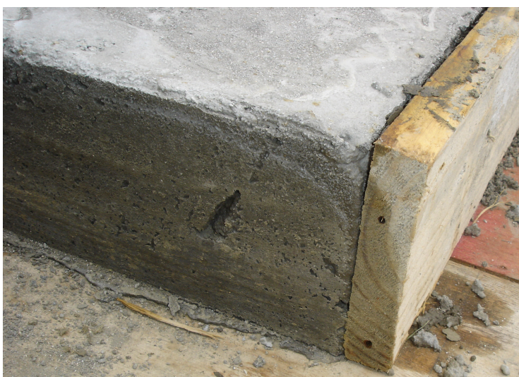
Figura 4. 42: desmolde do painel - remoção da lateral da forma de madeira.
