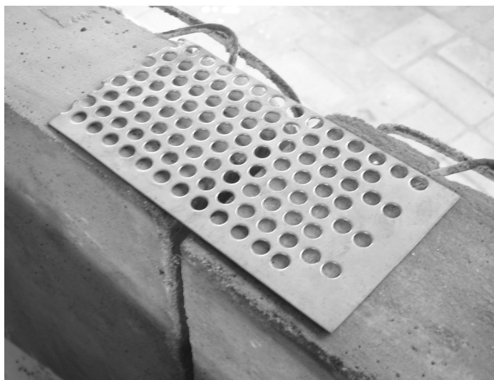
Figura 4. 19: fixação dos painéis de parede com chapa metálica perfurada.
