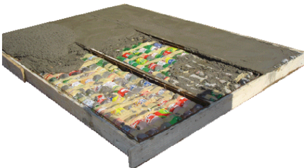
Figura 4. 39: preenchimento das laterais e da superfície do painel.
