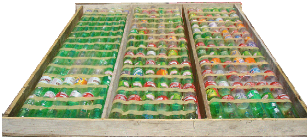
Figura 4. 38: colocação das colunas de garrafas plásticas e treliça de reforço.
