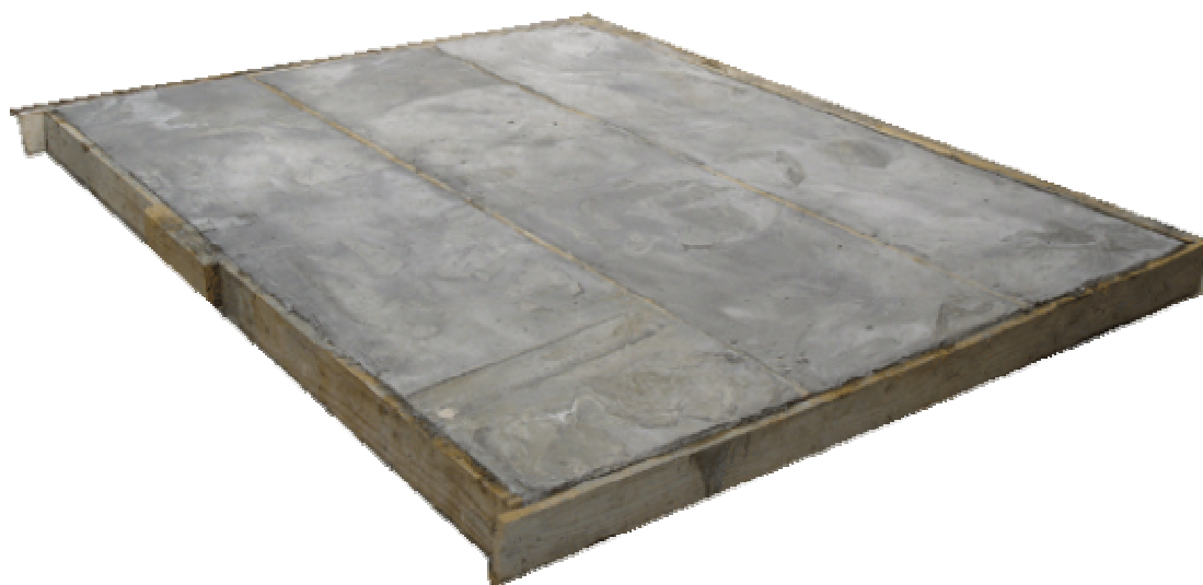
Figura 4. 40: painel finalizado na forma.
