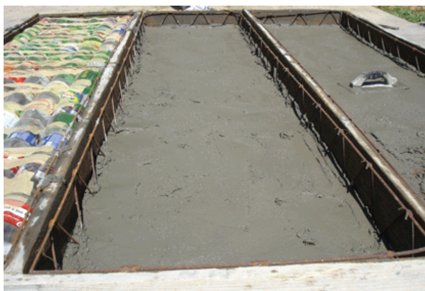
Figura 4. 37: base de 20mm de argamassa e treliças posicionadas.
