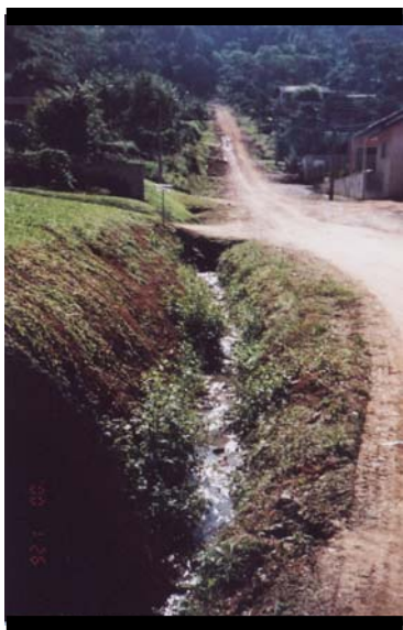
D.B. (jul./2005) FOTO 11 – curso d'água perene de pouca vazão que foi canalizado para ceder espaço às edificações e que escoou ao longo de uma via.
