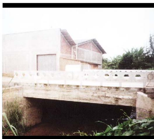
FOTO 15 – Foto comparativa. Ponte construída no mesmo local para permitir maior vazão nos períodos de precipitação elevada. Ao fundo Escola Municipal Ana Nagüel. (Jaraguá do Sul – SC, fev. de 2002).
