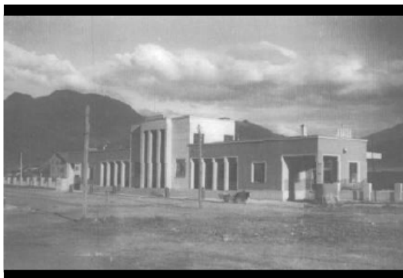
FOTO 1 – Vista da fachada principal da estação ferroviária construída na dec. de 40.
