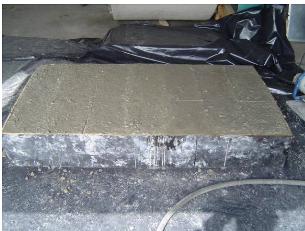
Figura 4.6 – Término da concretagem.
