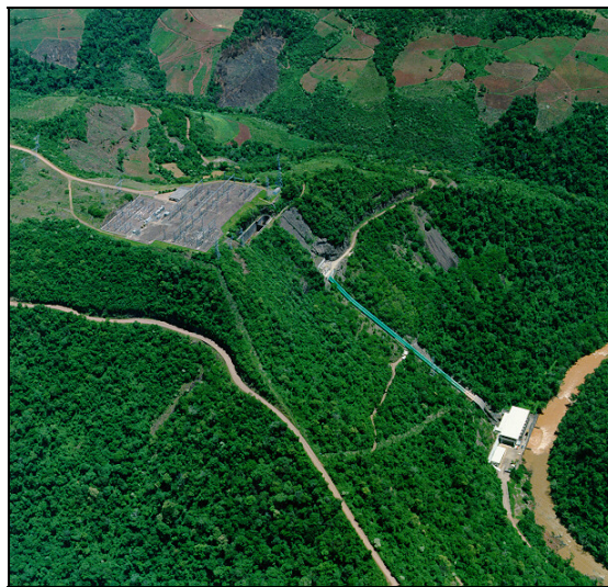
Figura 3.8 – Vista geral da UHE Passo Fundo.
