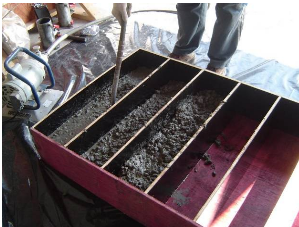
Figura 4.5 – Início da concretagem com vibrador.
