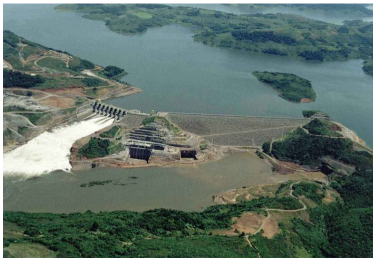
Figura 3.16 – Vista geral da UHE Machadinho.
