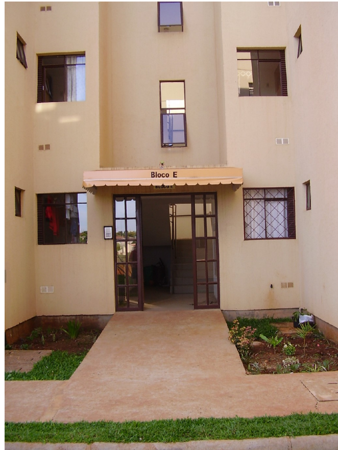
Ilustração 5C – Imagem do acesso do bloco.
