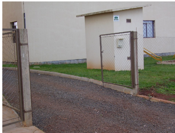
Ilustração 30 – Imagem do portão de um bloco aberto comprometendo a segurança dos outros blocos.
