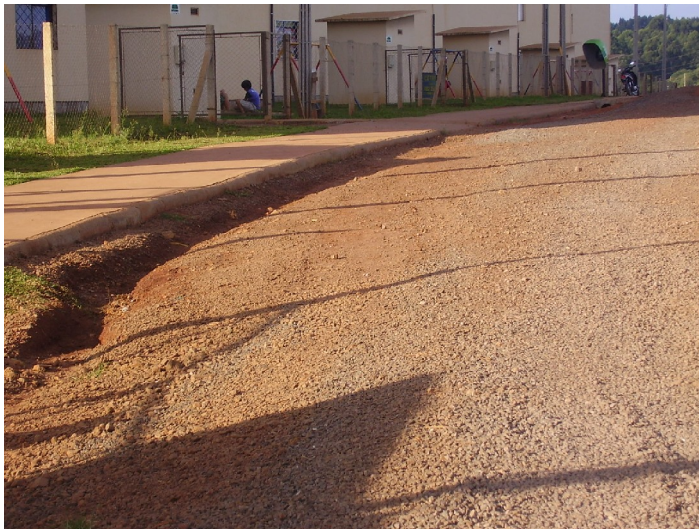
Ilustração 6C – Imagem da pavimentação da Rua Albino de Sá, que dá acesso ao Conjunto Habitacional Nova Esperança.
