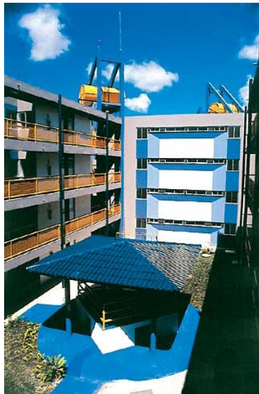
Ilustração 92 – Imagem da praça interna do Conjunto Habitacional Galápagos. FONTE: Revista Projeto Design, Jul./2003, Ed. 281.
