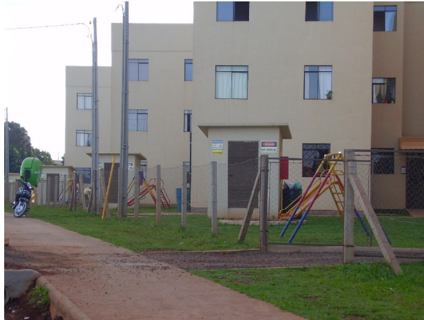
Ilustração 29 – Imagem dos acessos por bloco do Conjunto Habitacional Nova Esperança.
