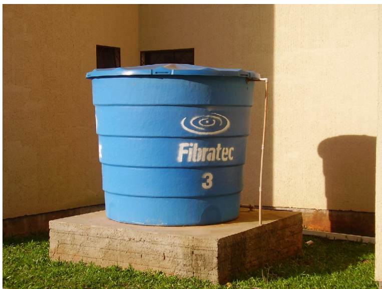
Ilustração 4C – Imagem do reservatório inferior que deveria estar subterrâneo.
