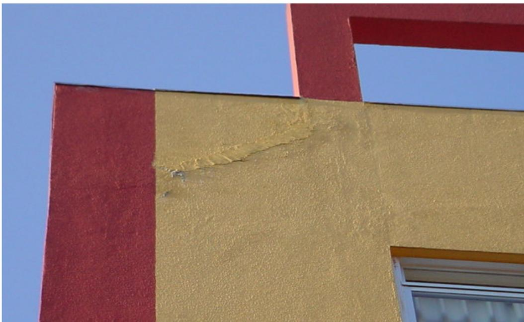
FOTOGRAFIA 1 – Recuperação da patologia causada pela dilatação térmica da laje de cobertura.
