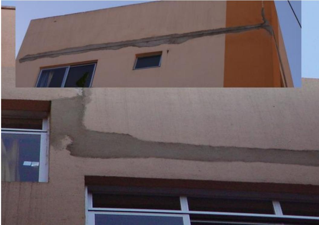
FOTOGRAFIA 2 - Recuperação parcial da patologia causada pela dilatação térmica da laje de cobertura.
