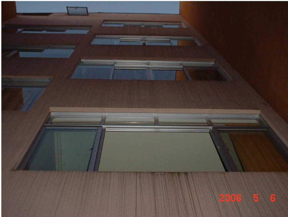
FOTOGRAFIA 9 – Foto da fachada sul do edifício II demonstrando o ponto G (pingadeira) e F (verga).
