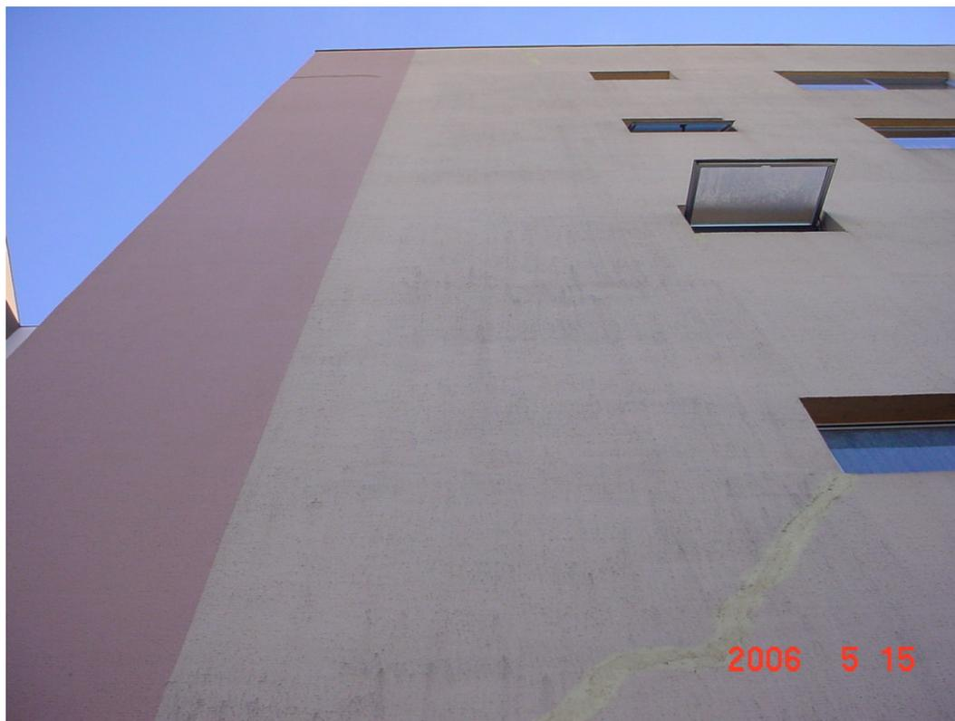
FOTOGRAFIA 3 – Recuperação das fissuras na fachada sul do Edifício 4.
