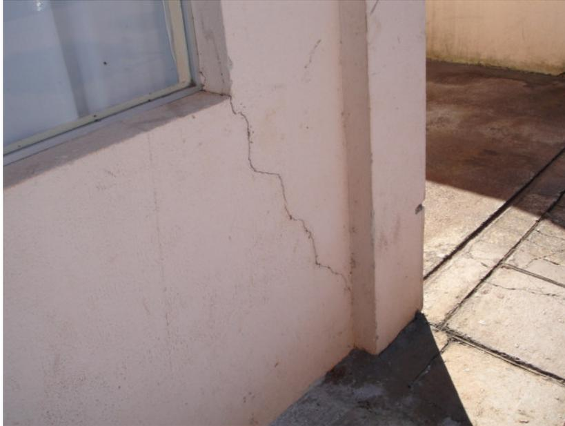
FOTOGRAFIA 14 – Trinca em 45 ° na alvenaria pela ausência de contraverga no edifício 2, fachada sul.
