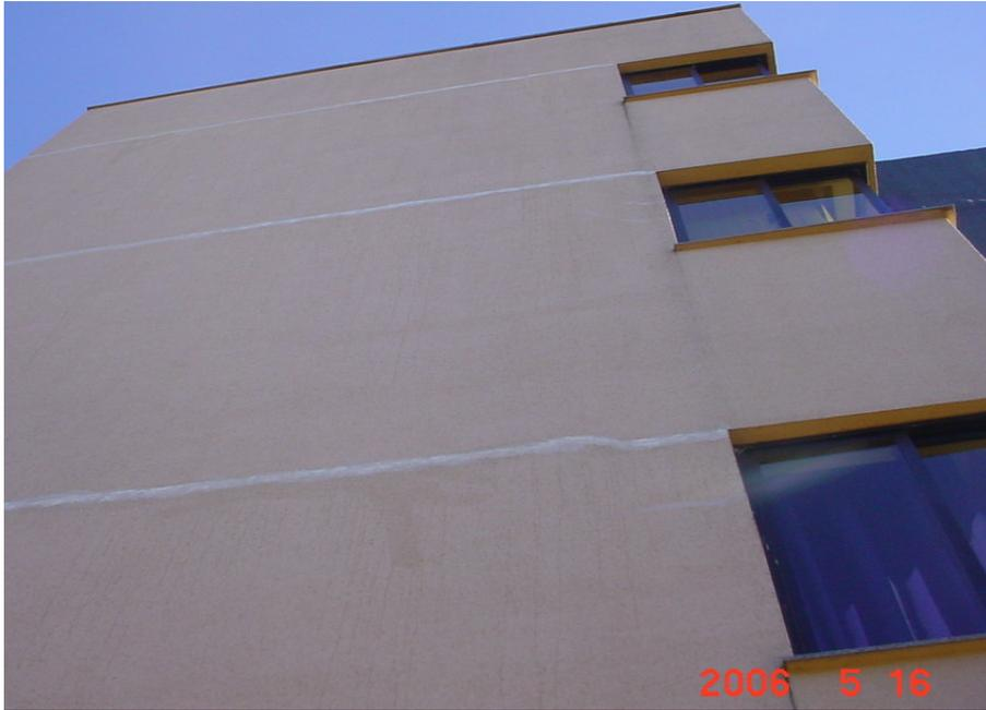
FOTOGRAFIA 5 – Fissuras e trincas na fachada sul do Edifício 7
