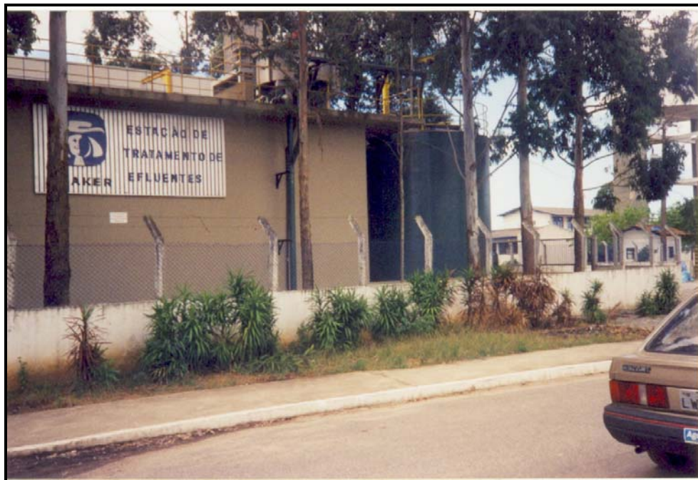
FOTO 7 - Detalhe da estação de efluentes do Entrepósito da Quaker em Itajaí
