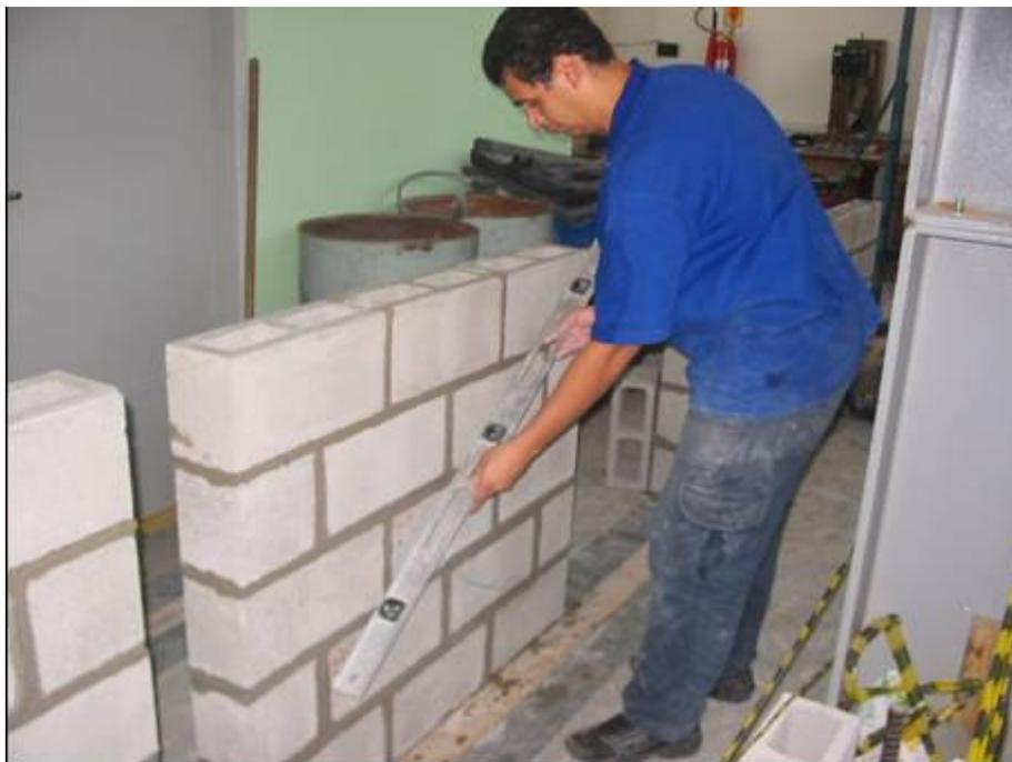
Figura 4.4 – Verificação da planeza e nível da mini-parede.
