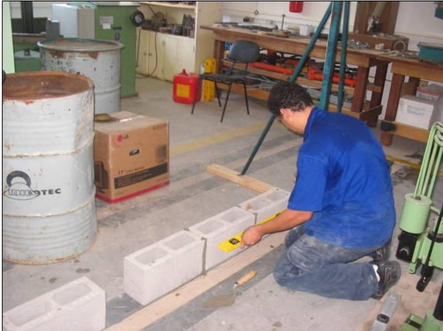
Figura 4.2 – Assentamento da primeira fiada das mini-paredes.
