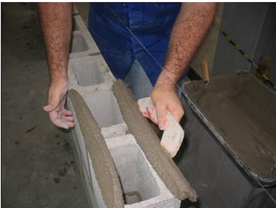
Figura 4.3 – Argamassamento utilizando a desempenadeira adaptada.
