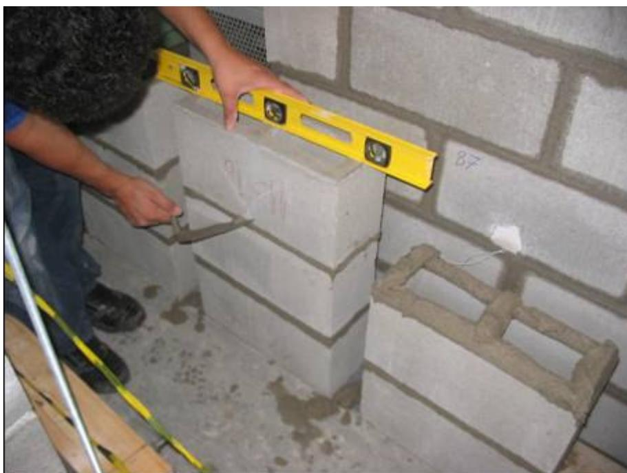
Figura 4.5 – Assentamento dos prismas e verificação do nível no topo.
