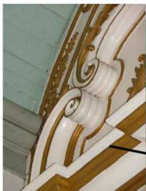
Ilustração 64 - Cimalha da pela-mor e entablamento.
