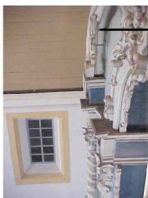
Ilustração 56 - Sistema de ancoragem de ornamentos do coroamento e do segundo corpo. Fotos da autora.
