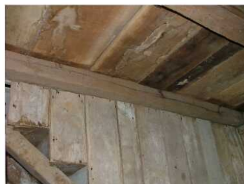
Ilustrações - Fendas no sentido longitudinal das faces direita e inferior do barrote F. Fotos: Angela do Valle
