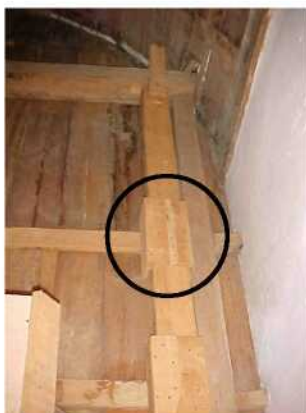
Ilustração 24 - Sambladura em prolongamento (tala). Foto da autora.
