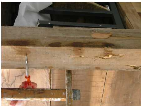
Ilustração 33 - Local de aplicação do gel e posterior remoção. Foto - Ângela do Valle.
