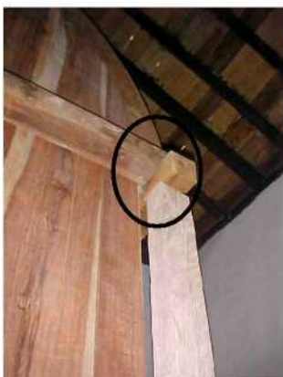
Ilustração 23 - Sambladura em ângulo (L). Foto da autora.
