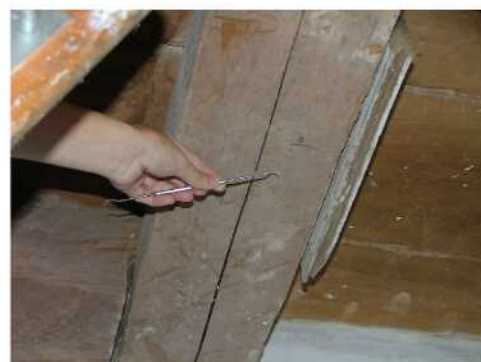
Ilustrações - Fendas no sentido longitudinal das faces direita e inferior do barrote F. Fotos: Angela do Valle
