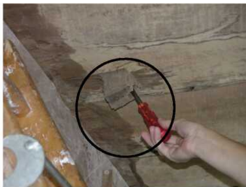
Ilustração 31 - Inspeção por perfuração. Igreja Nossa Senhora das Necessidades. Foto - Angela do Valle.
