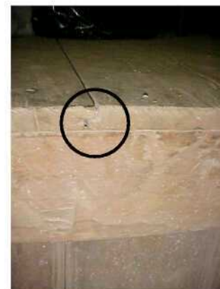
Ilustração 25 - Sambladura em borda (meia madeira).
