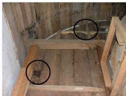
Ilustração - Perda de elemento estrutural; ataque de insetos xilófagos; deslocamento e mancha no suporte.
