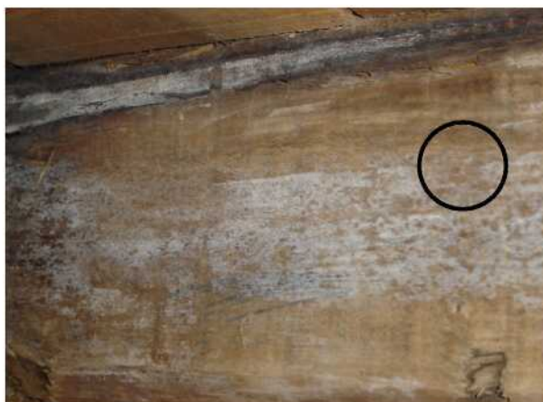
Ilustração 38 - Local de coleta de material para identificação de microorganismo no barrote B da tribuna do retábulo-mor da Igreja Nossa Senhora das Necessidades. Foto da autora. 2005.
