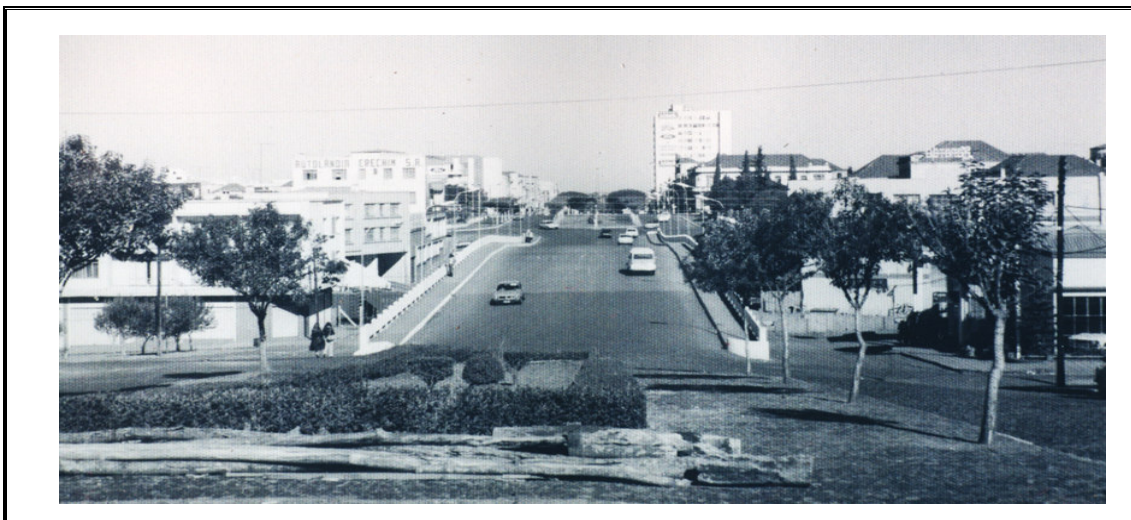
Foto 31 – Imagem do Viaduto Rubem Berta na década de 70. Fonte: Arquivo Histórico Municipal
