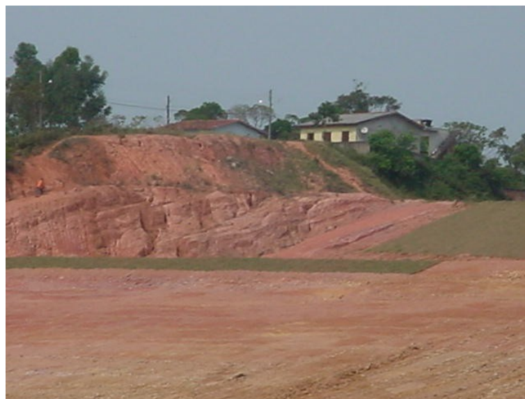
Figura 25 – Erosão às margens BR 101
