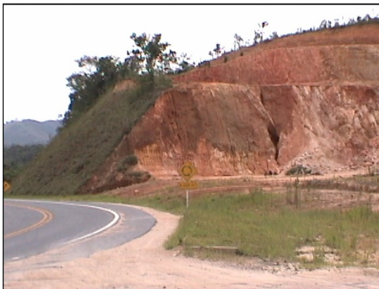
Figura 23 - Jazida de saibro às margens da BR 282
