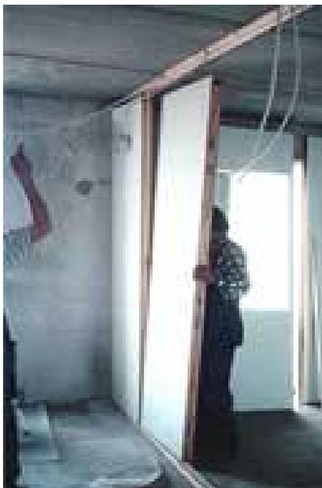
Figura 6.25: divisórias fixas desmontáveis
