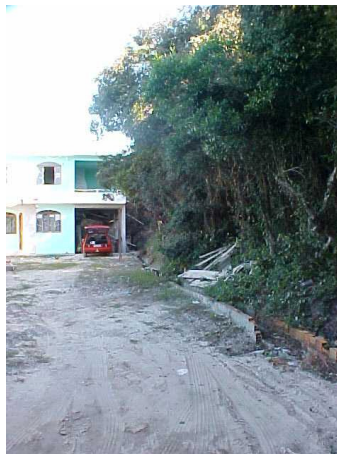
Figura 38 – Ocupação ao longo do cordão da duna fixa. Rua Jatobá - Santinho
