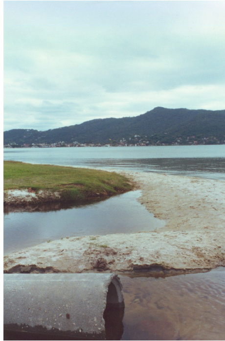
FIGURA 43: Esgoto sendo despejado nas águas da Lagoa da Conceição.
