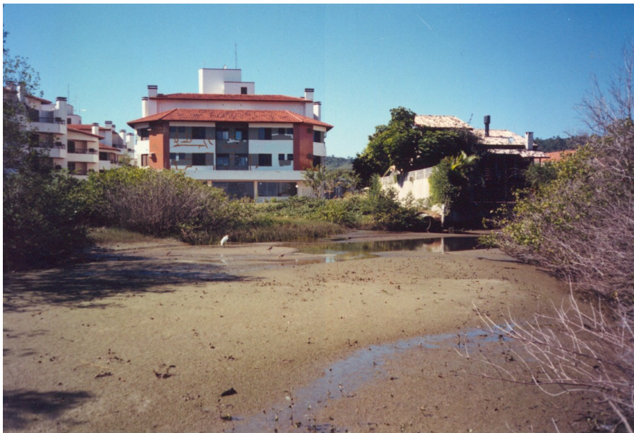
FIGURA 37: Edificações sobre o manguezal na praia de Ponta das Canas.
