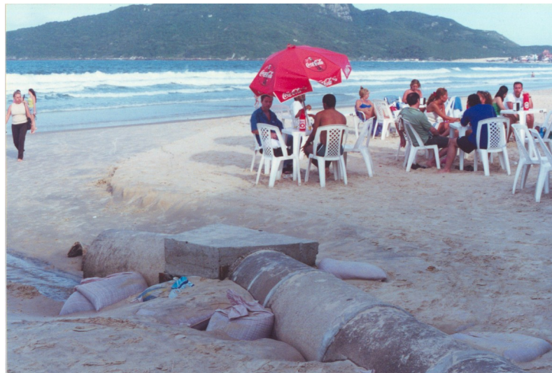
FIGURA 12: Praia de Ingleses – Convívio entre esgoto e veranistas.
