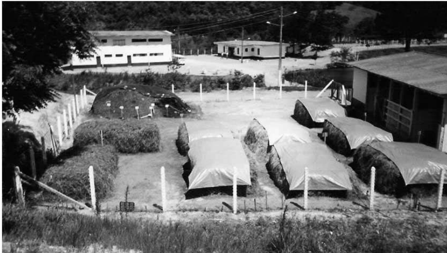
Figura 14: vista geral do pátio de compostagem
