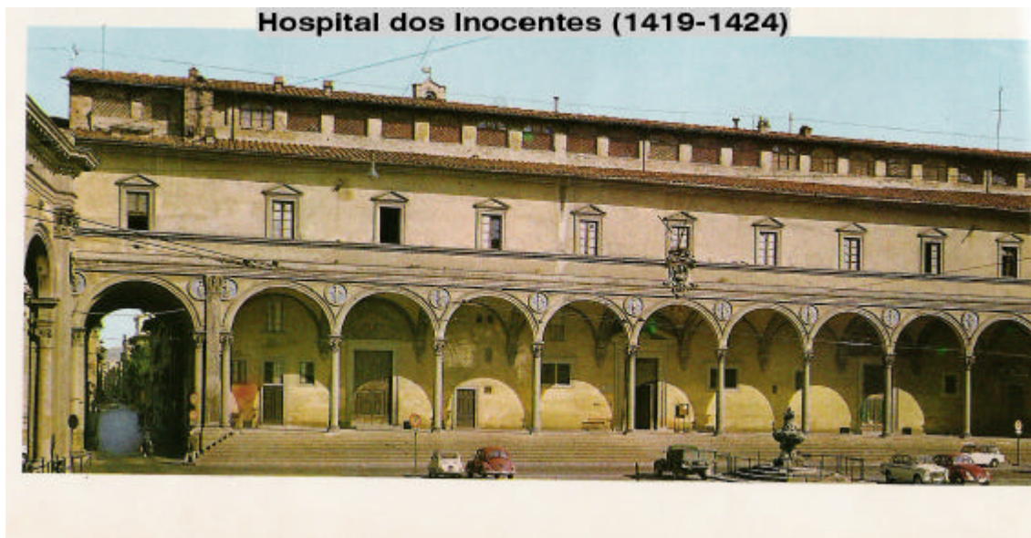
Figura 5 - Foto do Hospital dos Inocentes de Florença, Itália, obra do Arquiteto Filippo Brunelleschi, construída de 1419 a 1424, percebe-se o generoso pé direito no térreo. O terceiro pavimento é construção posterior que deturpa o edifício original. Fonte: Arte nos Séculos - Vol. III.
