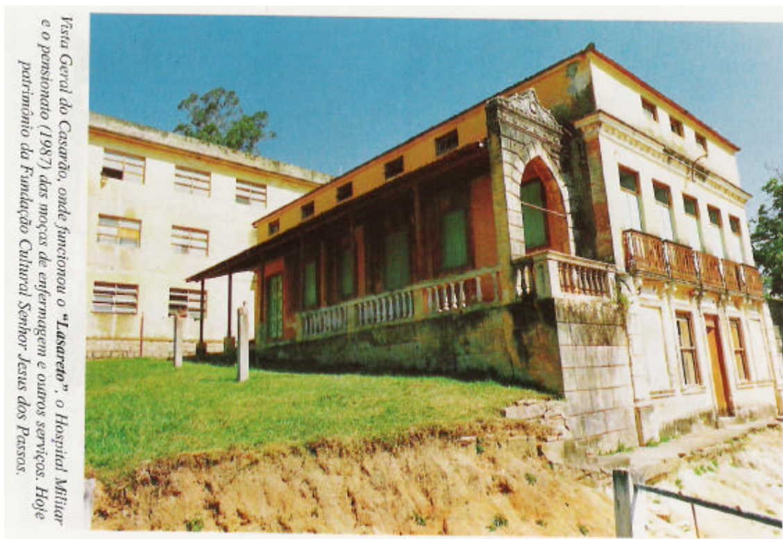
Figura 15 - Fonte: Pereira (1997:26). Nota-se o terceiro pavimento feito posteriormente e que deve ser removido por ser espúrio ao original. Ao fundo o prédio que serve de lavanderia do HC e que serviu antes como residência das Irmãs de Caridade. O Casarão recebeu diversas denominações ao longo da sua história como Hospital dos Lázaros, Escola, Hospital dos Variolosos, etc. Atualmente o Casarão está restaurado, pintado e com muito melhor aspecto do que da foto acima.
