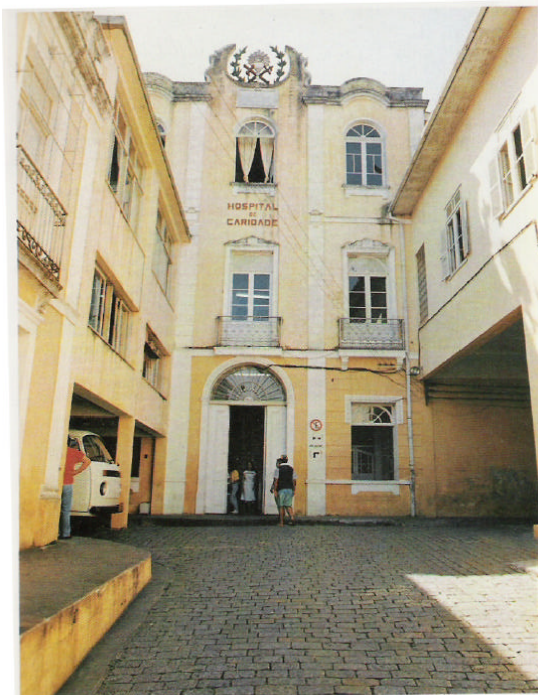
Entrada principal do Imperial Hospital de Caridade, apresentando, ao alto, brasão símbolo da Eucaristia. Abaixo, placa de mármore com dizeres alusivos a Dom Pedro II em 1845. Essa estrutura é mantida até hoje e resgatada após o incêndio de 1994.
