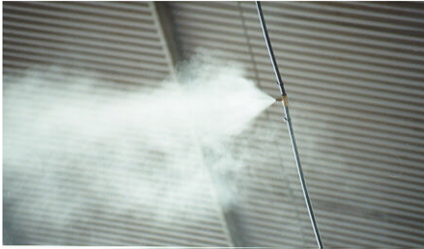
Figura 2.6 - Névoa artificial produzida por sistema de microaspersão.
