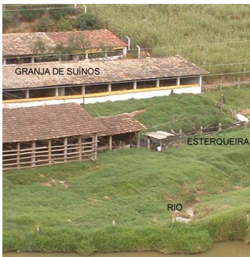
FIGURA 30: Granja de suínos e esterqueira descoberta situadas junto à rede de drenagem, situação típica encontrada em toda a bacia do rio Coruja-Bonito.
