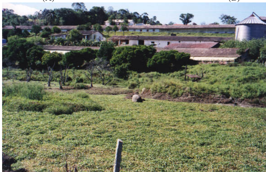
FIGURA 31: (A) Esterqueira (buraco no solo) em área baixa do terreno, que capta, além dos dejetos da granja de suínos, as águas pluviais. Devido ao subdimensionamento, foi aberta uma canalização a céu aberto (B) para levar os dejetos até uma lagoa, mais abaixo, que se encontra completamente eutrofizada (C).
