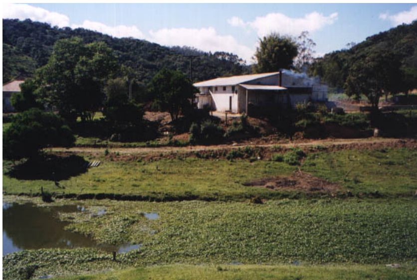
FIGURA 33: Lagoas de tratamento de efluentes de um abatedouro, completamente eutrofizadas.
