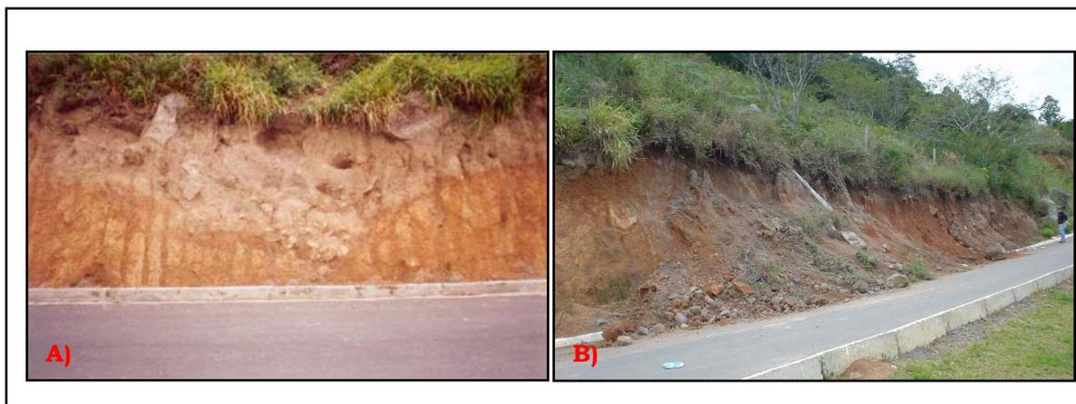
Figura 17: Fotos da via de acesso ao heliponto da Polícia Militar: na primeira (A), tirada em julho de 2003, observa-se o nítido depósito de vertente. Na segunda foto (B), datada de maio de 2004, nota-se a instabilidade da encosta, devido às próprias características do material, bastante inconsolidado, mas principalmente pelo corte elaborado para a construção da via. (Foto: Saito, 2003/2004)
