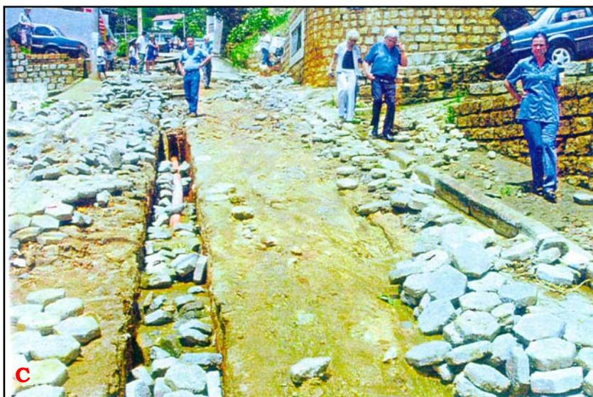
Figura 14: Ruas parcialmente destruídas com calçamento feito em lajotas de cimento e asfalto: A e B) Morro da Cruz; C) Morro do Horário (Fonte: Arquivo DEDC-SC, 2001)
