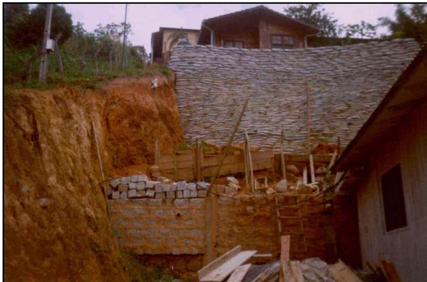
Figura 26: Saco dos Limões: exemplo de contenção que utiliza sacos com conchas trituradas e areia (*rip-rap*) feita para estabilizar o talude, em decorrência de acidente já ocorrido. (Foto: Saito, julho/2003)
