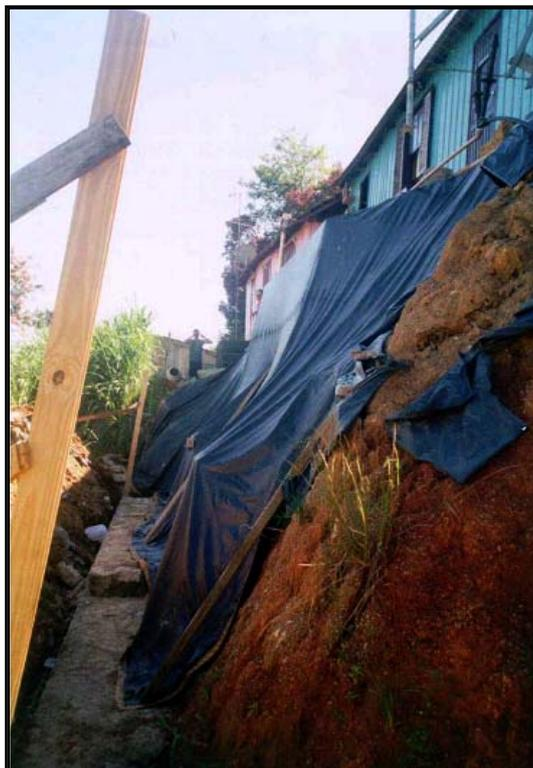
Figura 47: Morro da Mariquinha - obra de recuperação feita pelo proprietário em decorrência de um deslizamento do corte elaborado para a construção da casa (Foto: Pellerin, 2002).
