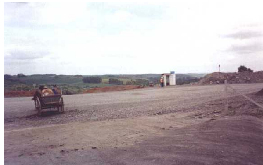
FOTO 11: Posto de controle em estrada particular da Petrobrás-SIX FONTE: Acervo do autor – 2003
