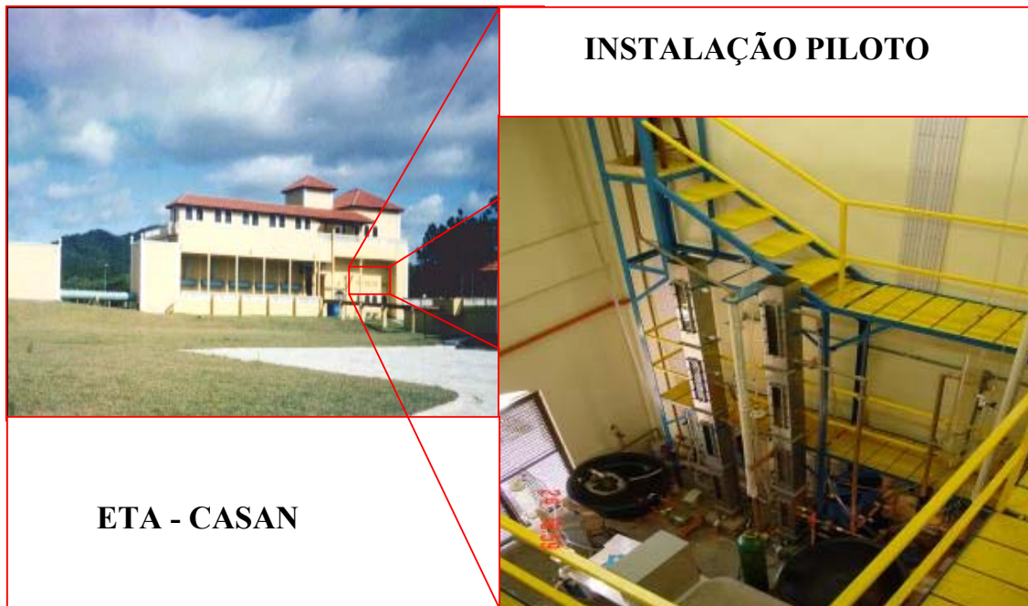
Figura 2.1 – Vista geral da ETA da Lagoa do Peri e da instalação piloto
