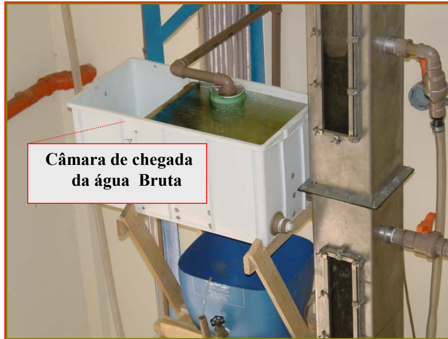
Figura 2.4 – Foto da câmara de chega da água bruta
