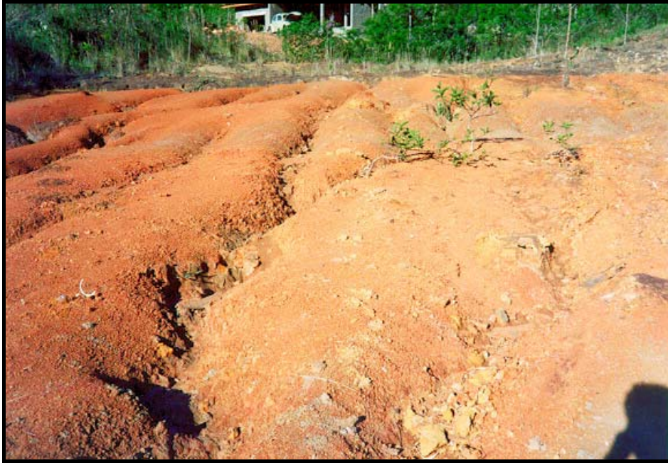
Figura 2.3 – Erosão característica do horizonte C de granito (Santos,1997)
