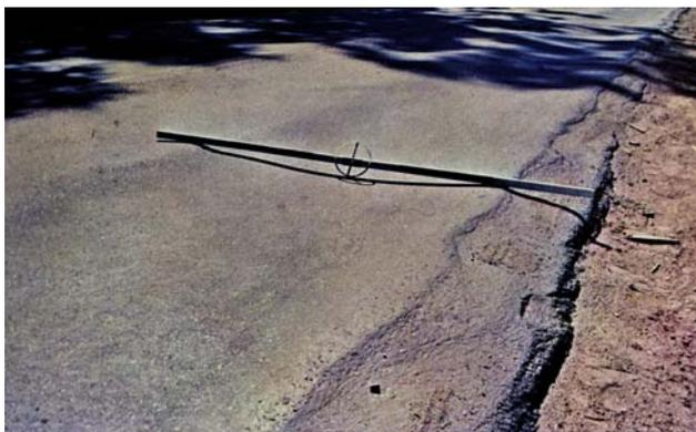
**Figura 2.4 – Afundamento na trilha de roda**
