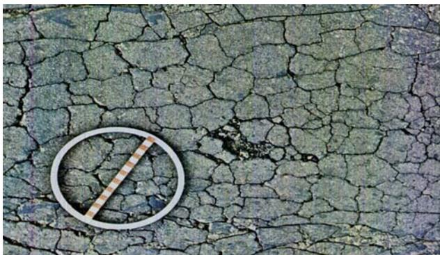
**Figura 2.2 – Trincamento FC-3**
