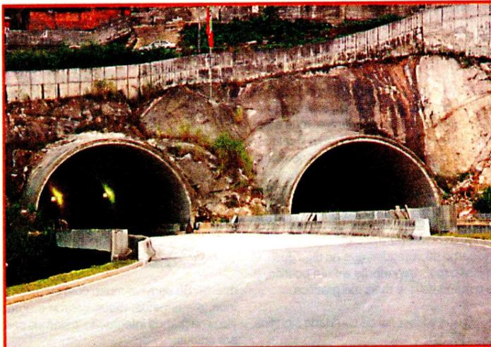
Os túneis contarão com sistemas de prevenção contra incêndios e de televisão para controlar a passagem dos veículos
