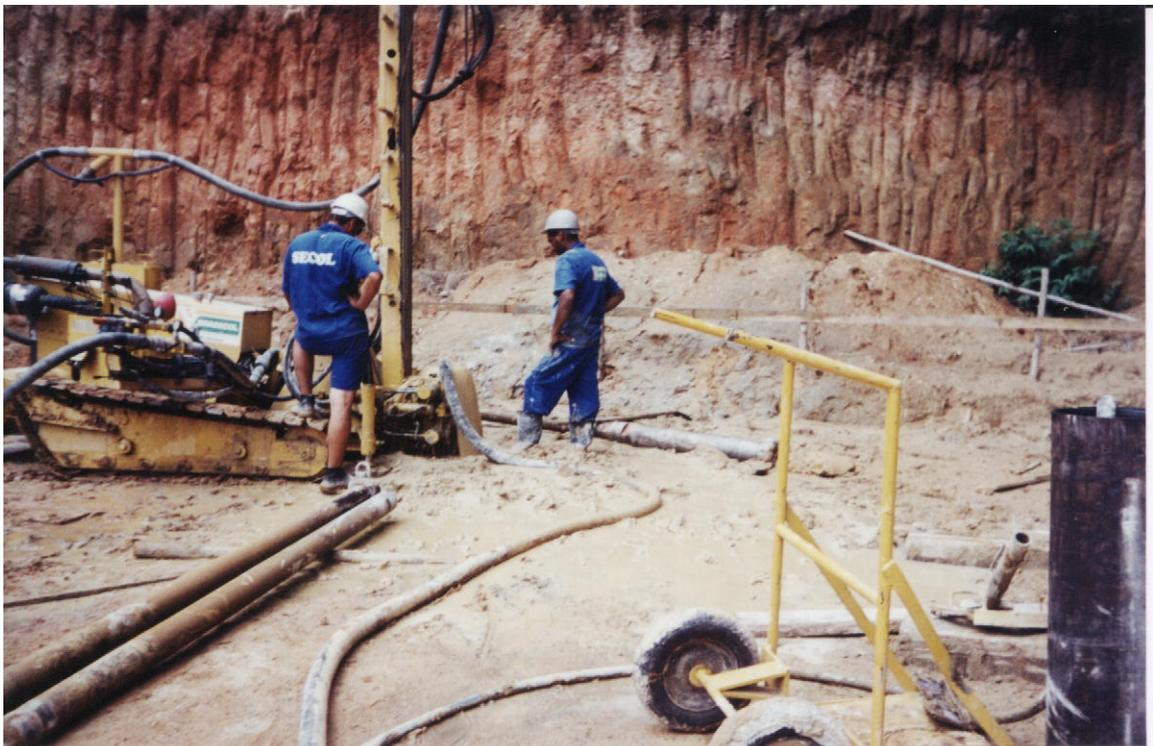
*Foto 11 – Concretagem da estaca e saída da lama do furo.*
