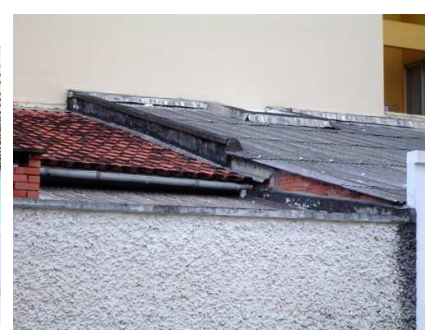
Aproximação F – A pouca diferença de altura não justifica o uso de elementos intermediários e evidencia a diferença de inclinação ou o contraste dos materiais.
