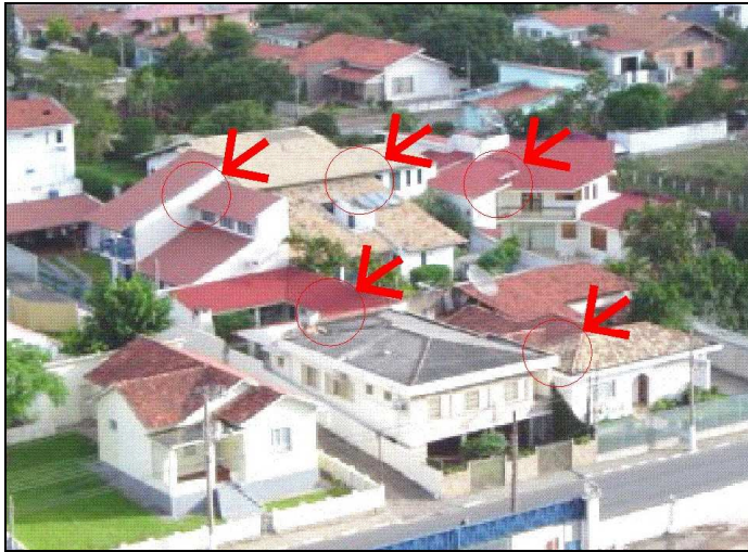
Figura 18 - Conflito na composição de planos de coberturas. Tubarão-SC.
