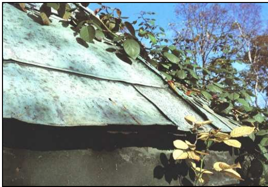
Figura 03 – Telha metálica de cobre.
