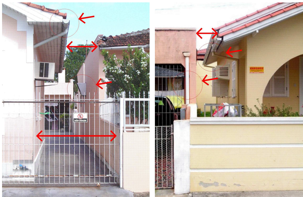
Figura 48 – Destaque no aproveitamento favorável do afastamento entre as coberturas e a manutenção dos componentes funcionais. Balneário, Florianópolis-SC
