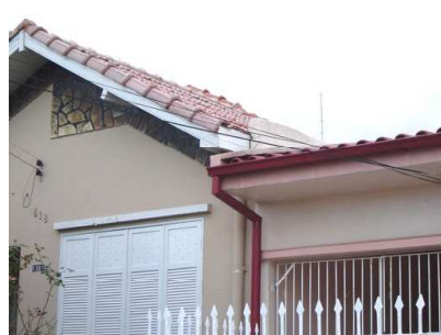
Aproximação D – Disposição de platibanda incompleta e sem calha intermediária, ocasionando o deságüe sobre a cobertura vizinha.
