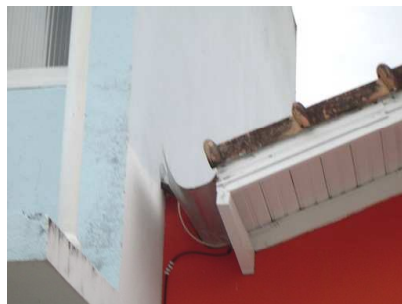
Aproximação A – Chapa de aço galvanizado utilizado como calha e engastado no reboco da fachada. A calha não apresenta acabamento com rufo junto a parede.
