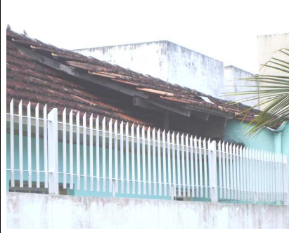
Aproximação F – A pouca diferença de altura não justifica o uso de elementos intermediários e evidencia a diferença de inclinação ou o contraste dos materiais.
