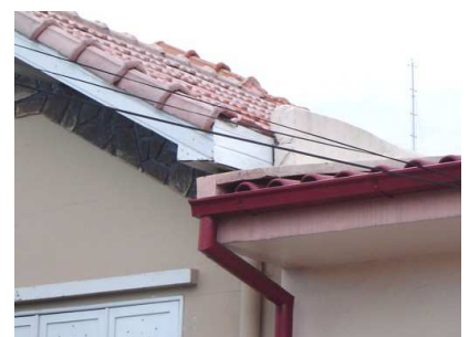
Aproximação D – Disposição de platibanda incompleta e sem calha intermediária, ocasionando o deságüe sobre a cobertura vizinha.
