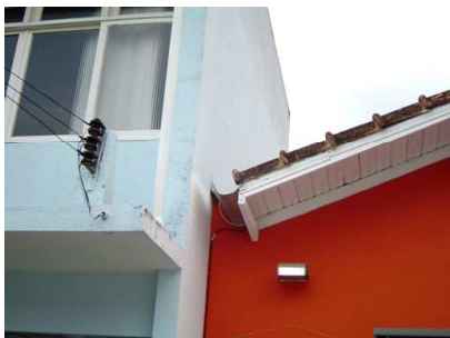
Aproximação A – Chapa de aço galvanizado utilizado como calha e engastado no reboco da fachada. A calha não apresenta acabamento com rufo junto a parede.
