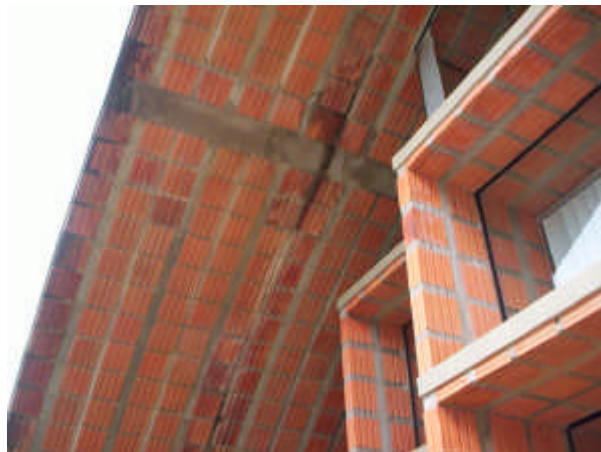
Ilustrações 4.67. e 4.68. Casa do Lago: espessura da cobertura e junção entre painéis
