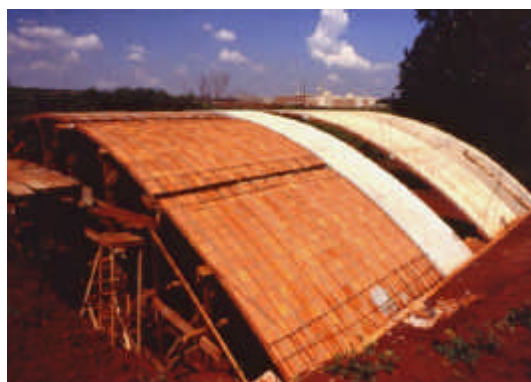
Ilustrações 4.69. e 4.70. Painéis abóbadas: produção e montagem
