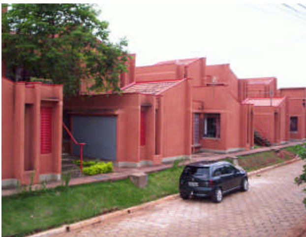
Ilustrações 4.27. e 4.28. Arranjo estrutural: paredes enrijecedoras
