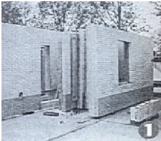
Ilustrações 2.10. e 2.11. Painéis “sandwich” na fábrica e locação na obra (HOBBS; DAWOOD, 2000)
