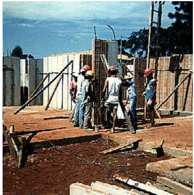
Ilustrações 4.48. e 4.49. Levantamento manual e escoramento dos painéis (UNICAMP, 1990)
