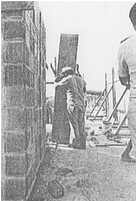
Ilustrações 4.48. e 4.49. Levantamento manual e escoramento dos painéis (UNICAMP, 1990)
