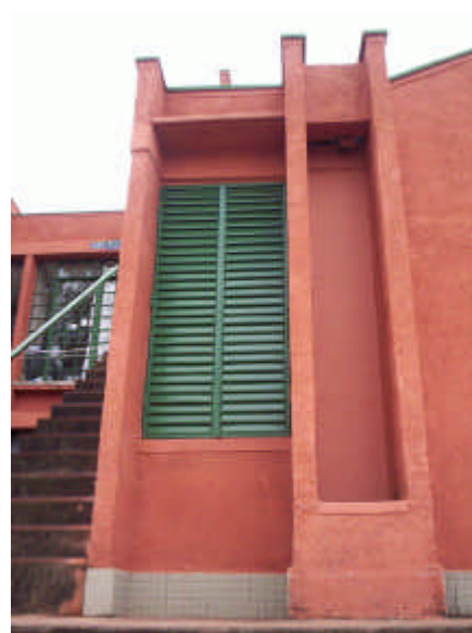
Ilustrações 4.39. e 4.40. Subsistema parede/oitão (UNICAMP, 1990) e pingadeira
