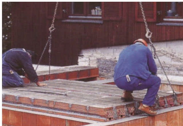
Ilustração 2.5. Placa cerâmica pré-tensionada (SARRABLO, 2001)
