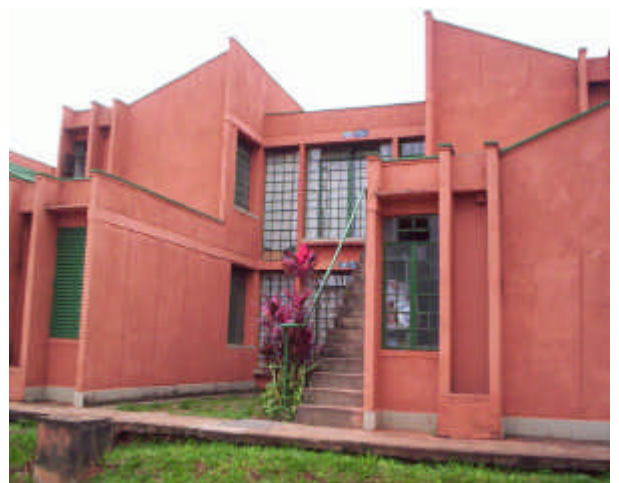
Ilustrações 4.27. e 4.28. Arranjo estrutural: paredes enrijecedoras
