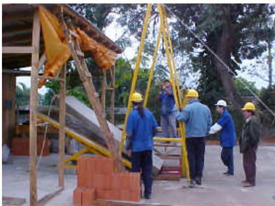
Ilustrações 4.94. e 4.95. Içamento do painel
