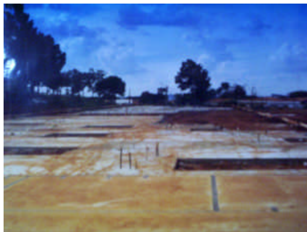
Ilustrações 4.41. e 4.42. Moradia Estudantil: fundação tipo radier (UNICAMP, 1990)
