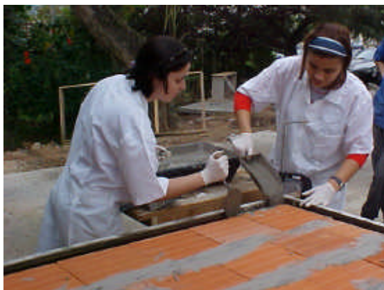
Ilustrações 4.92. e 4.93. Aplicação da argamassa de reforço e da argamassa de revestimento
