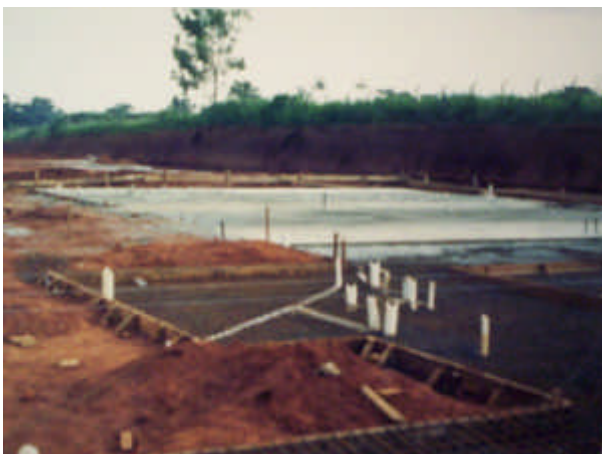
Ilustrações 4.41. e 4.42. Moradia Estudantil: fundação tipo radier (UNICAMP, 1990)
