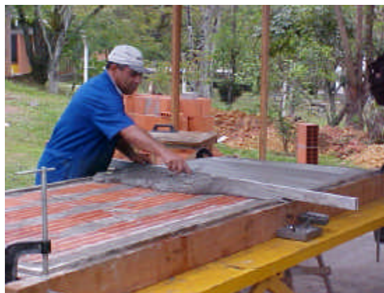
Ilustrações 4.92. e 4.93. Aplicação da argamassa de reforço e da argamassa de revestimento
