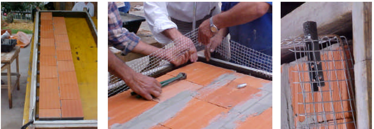
Ilustrações 4.89., 4.90. e 4.91. Colocação dos blocos e da armadura perimetral
