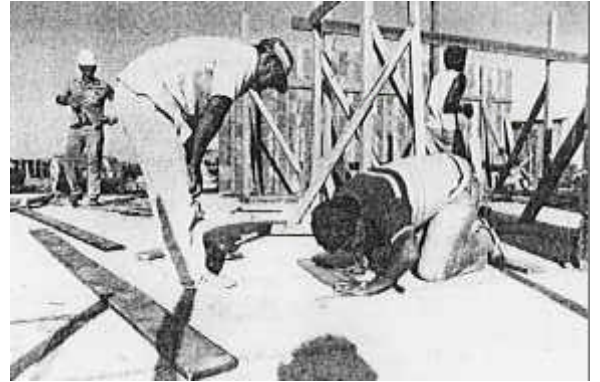
Ilustrações 4.46. e 4.47. Içamento (BARTH, 1992) e pintura do radier (MINTER/PNUD, 1989)
