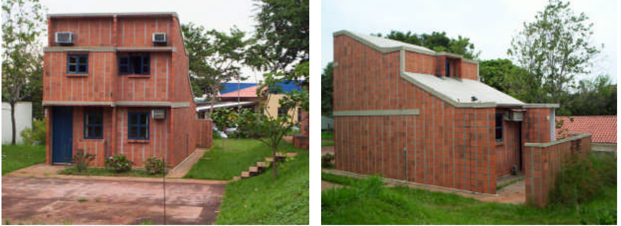
Ilustrações 4.18. e 4.19. Aspecto das fachadas e cobertura do protótipo de sobrado da UNICAMP
