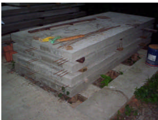
Ilustrações 4.98. e 4.99. Painéis de cobertura: resolução estrutural
