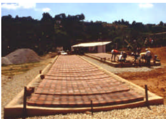
Ilustrações 4.69. e 4.70. Painéis abóbadas: produção e montagem
