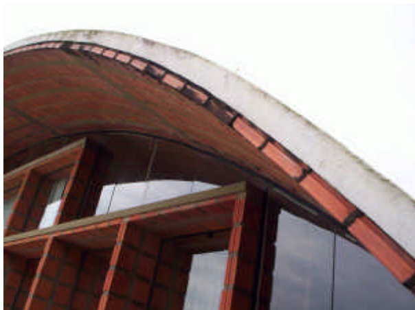
Ilustrações 4.67. e 4.68. Casa do Lago: espessura da cobertura e junção entre painéis
