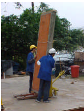
Ilustrações 4.96. e 4.97. Transporte e empilhamento dos painéis
