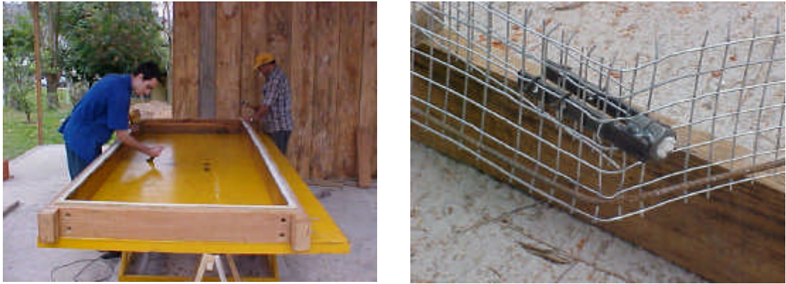
Ilustrações 4.87. e 4.88. Aplicação de desmoldante e armadura perimetral
