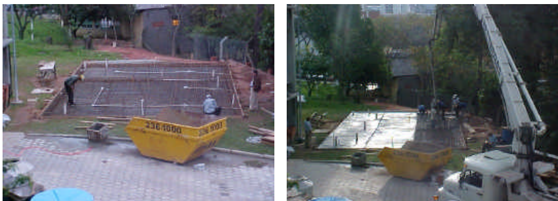
Ilustrações 4.81. e 4.82. Anexo LMCC: fundação tipo radier
