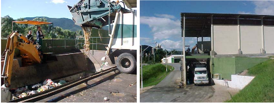
Figura 7.1 Operação de transferência de lixo na estação de transbordo de Itacorubi
