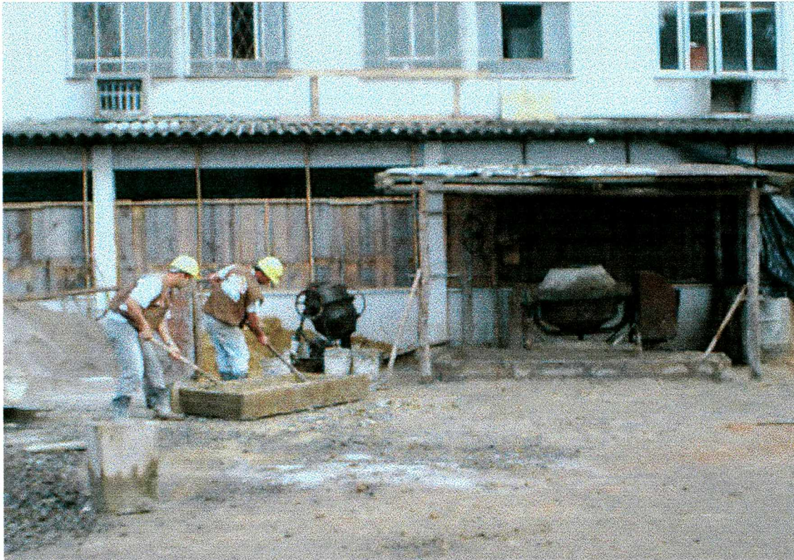
Foto 4.1 – Atividade não programada preparação de concreto manualmente. (Fonte – arquivo do autor)
