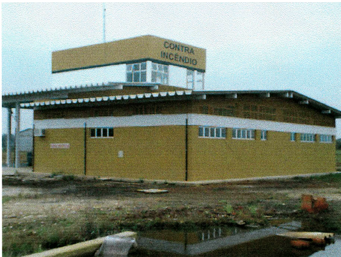
Foto 3.5 – Fotografia da obra do corpo de bombeiros do aeroporto regional de Forquilha.
