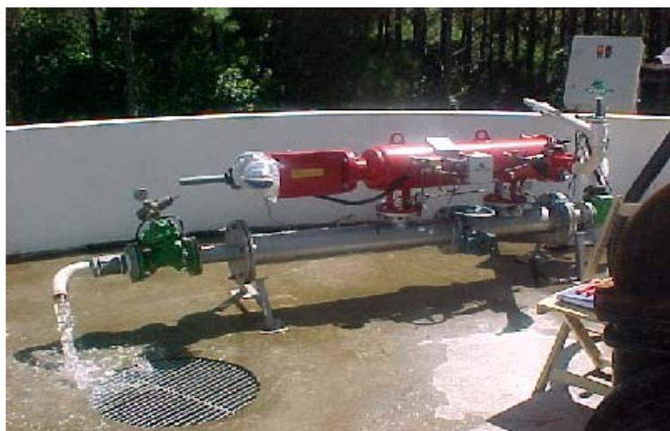
Figura 12. Foto do filtro piloto modelo SAF 3000 autolimpante
