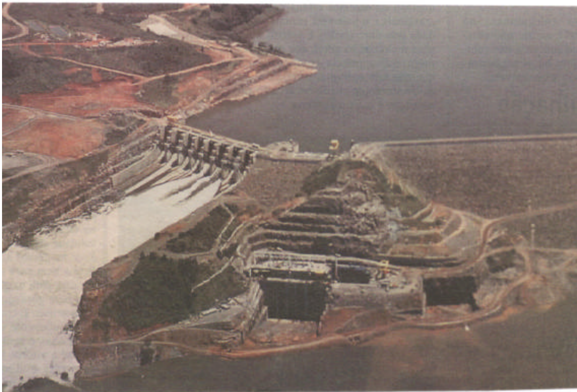
Figura 22. Vista aérea das obras da UHE de Machadinho.
