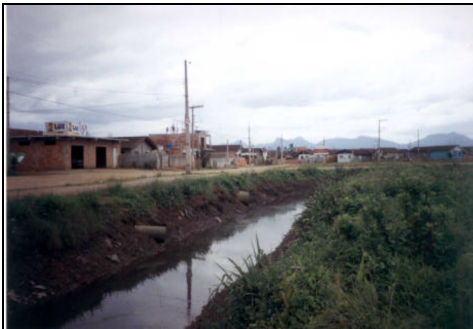
Figura 8- Joinville-SC: escoamento de esgoto in natura
