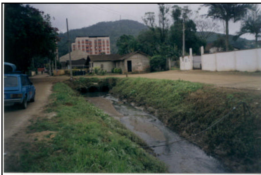
Figura 5- Joinville-SC: esgoto sem tratamento jogado em córrego no bairro Boa Vista
