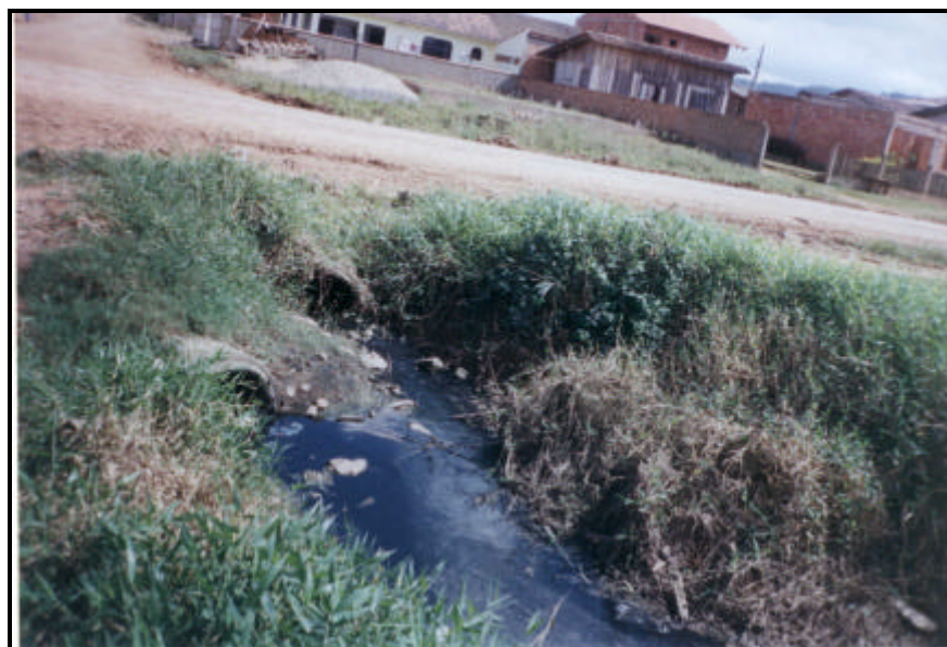
Figura 9- Joinville-SC: escoamento de esgoto in natura
