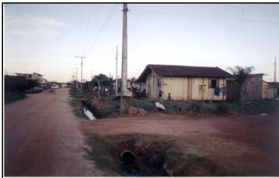
Figura 4- Joinville-SC: esgoto a céu aberto no bairro Jardim Paraíso
