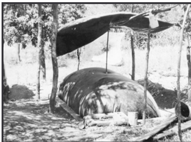
Figura 3 — Biodigestor de Batelada.
