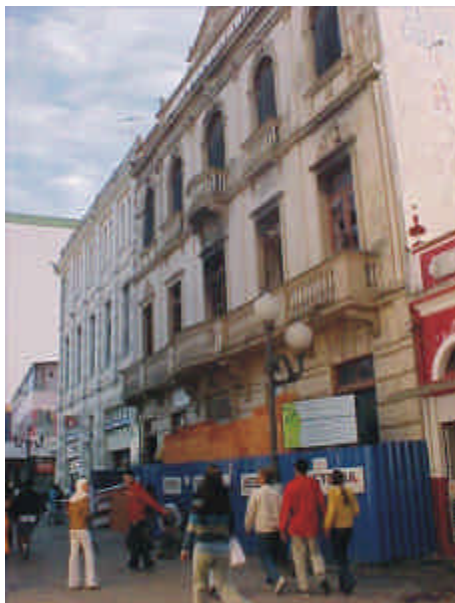
Figura 27: Recuperação do Casario pelo Projeto Renovar, Rua Cons. Mafra. Fonte: Autora, 2003.
