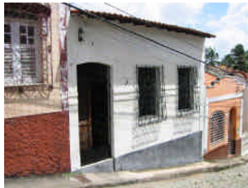
Figura 42: Casas antigas, comumente vistas na área. Fonte: Autora, 2003.
