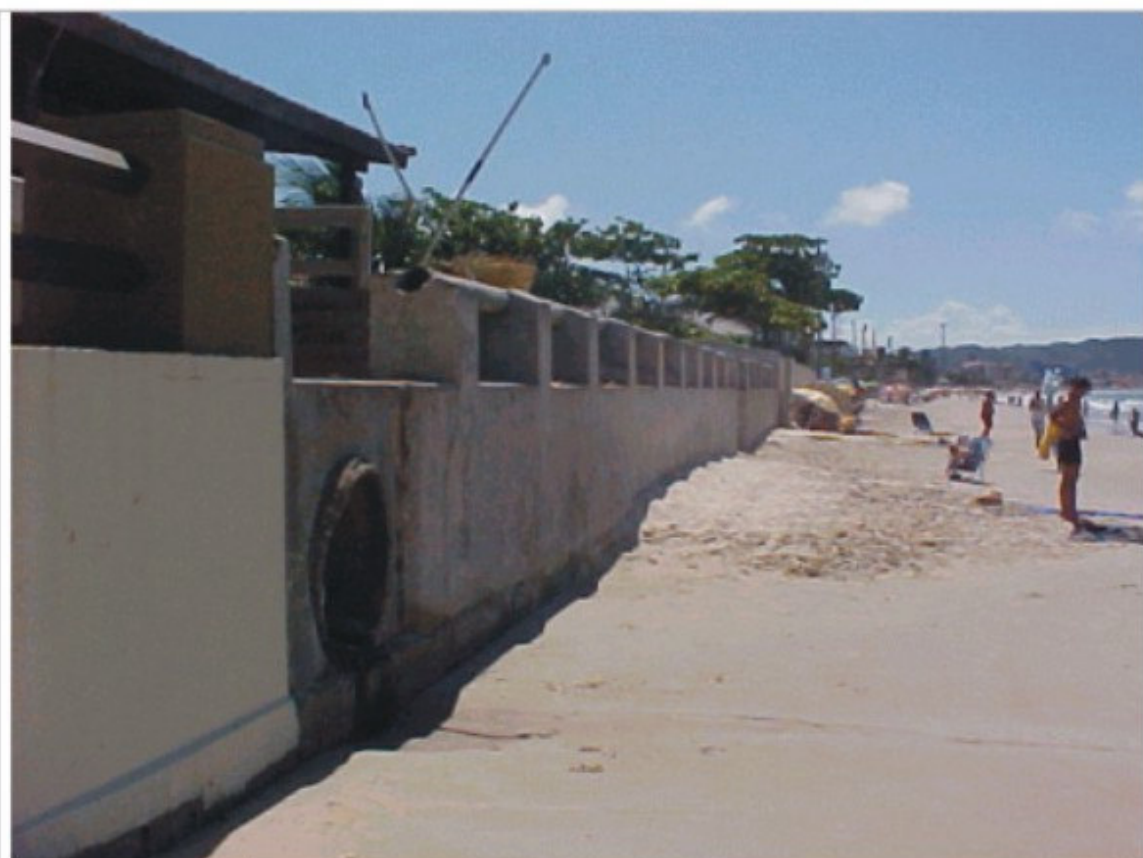
40c - Muros de proteção (detalhe)
