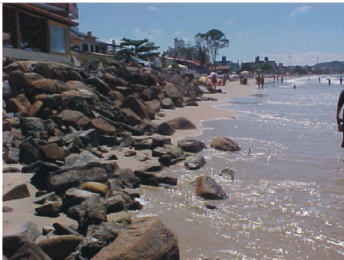
40a - Enrocamento para proteção contra a erosão marinha
