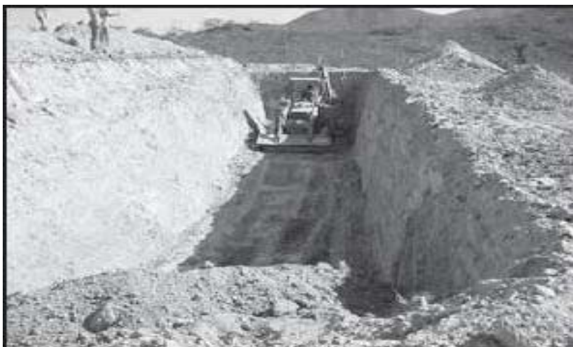
Aterro de Catas Altas - MG
