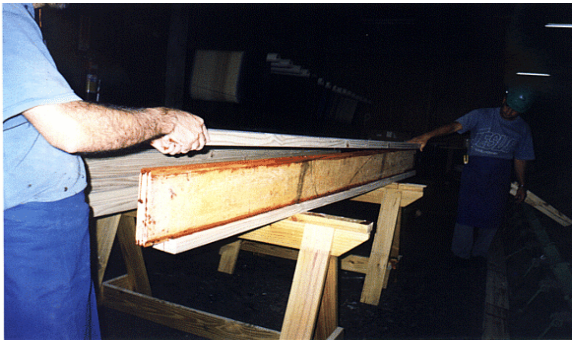
FOTO 35 – União de mesa e alma da Viga “T”
