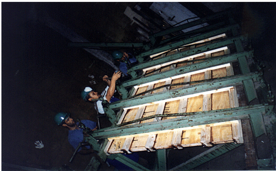
FOTO 36 – Prensagem manual das Vigas
