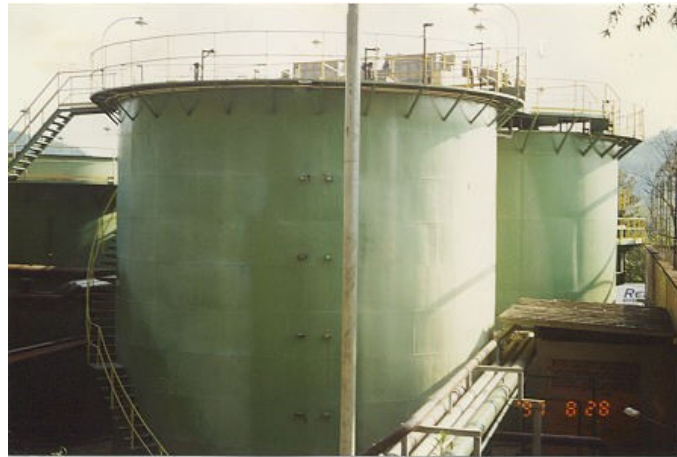
Figura 13 - Tanques de equalização
