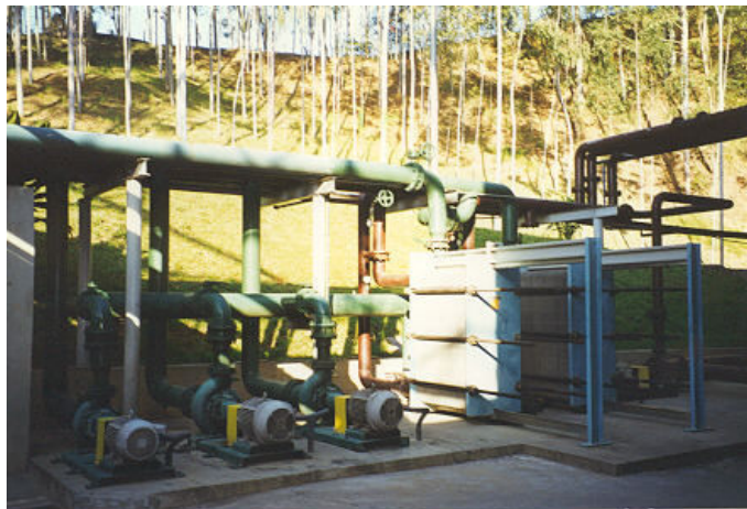
Figura 14 - Trocadores de calor
