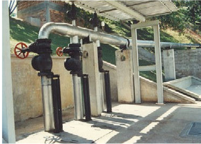
Figura 11 – Captação e gradeamento
