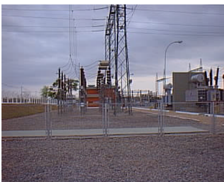
Figura 14 - Plataforma com os equipamentos afixados em prisioneiros. Fonte SE – Coxipó - MT.
