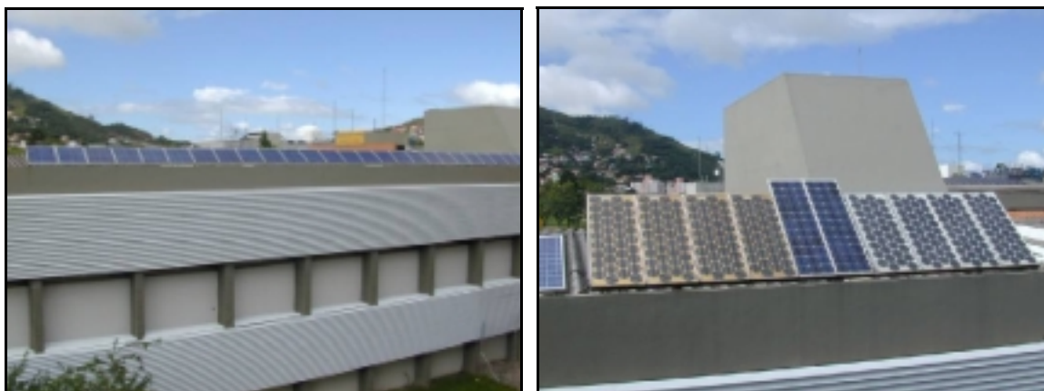
Fig. 4.3: Foto dos módulos instalados no Inep.
