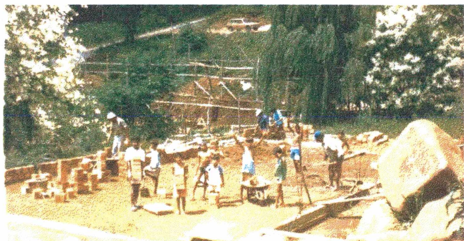
Mutirões de Construção da Casa da Comunidade do Morro do Horácio
