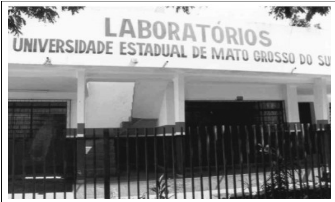
Figura 5 Fachada do prédio residencial adaptado onde funcionam os Laboratórios Uems de química, biologia e informática, além de um biotério e serpentário à disposição da U.E de Maracajú, distante duas quadras da sede atual.
