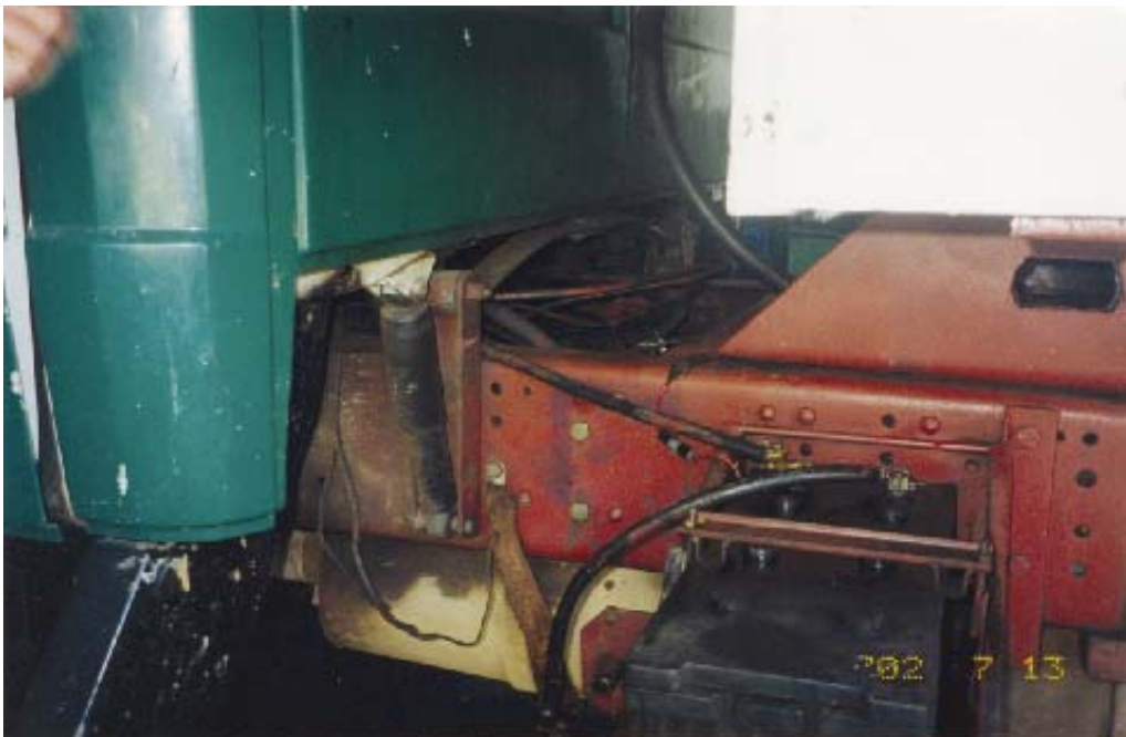
FIGURA 6 - BOMBA HIDRÁULICA E TOMADA DE FORÇA
