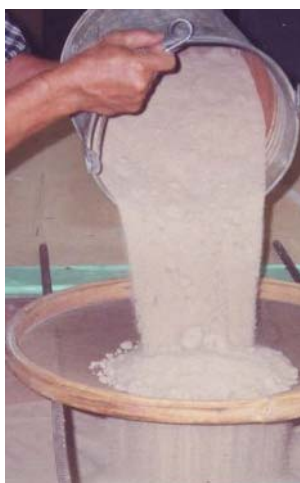
FIGURA 3.2 – Peneiramento e armazenamento da areia na caixa
