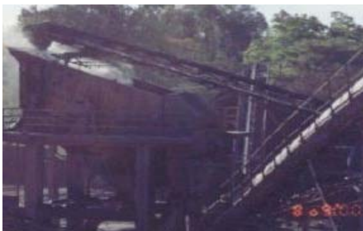
FIGURA 2.4 - Injeção de água no sistema em via úmida na peneira
