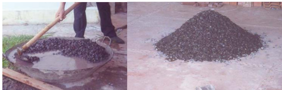
FIGURA 3.7 – Lavagem e escoamento do excesso de água da brita 1
