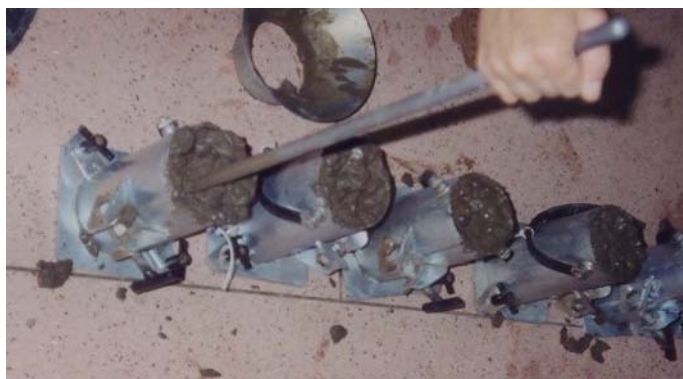
FIGURA 3.13 – Moldagem dos corpos-de-prova de concreto
