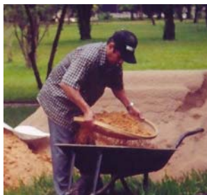
FIGURA 3.1 – Depósito e peneiramento da areia antes da secagem
