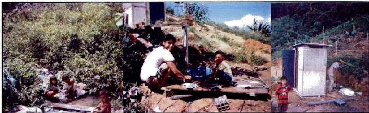
Figura 12. Pontos de água e banheiro construído pela FUNASA
