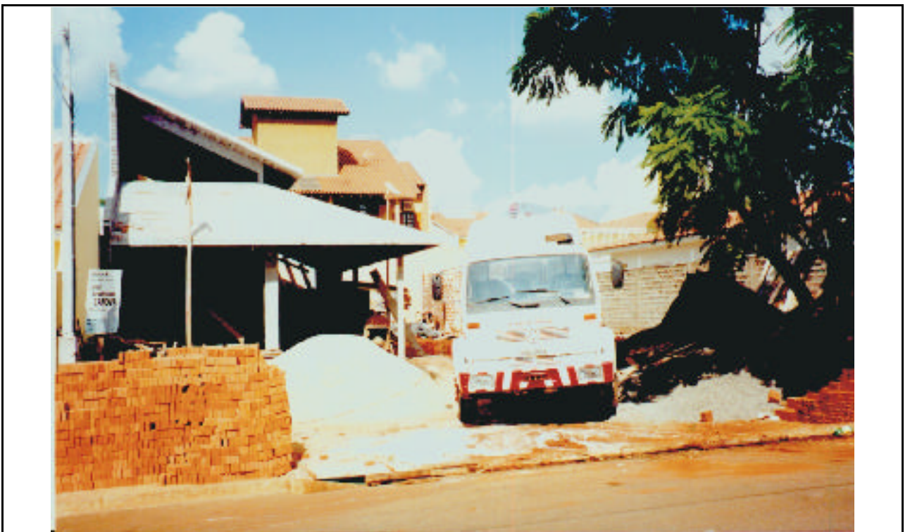
FIGURA 19 – Vista do caminhão de concreto usinado.
