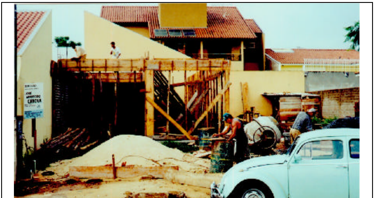
FIGURA 12 – Vista da concretagem da laje e vigas do 1º pavimento.
