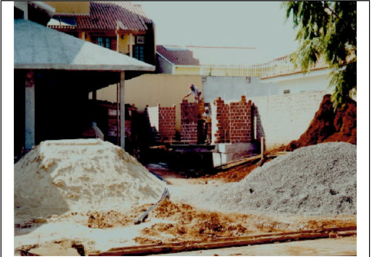
FIGURA 16 – Vista geral da execução da obra.
