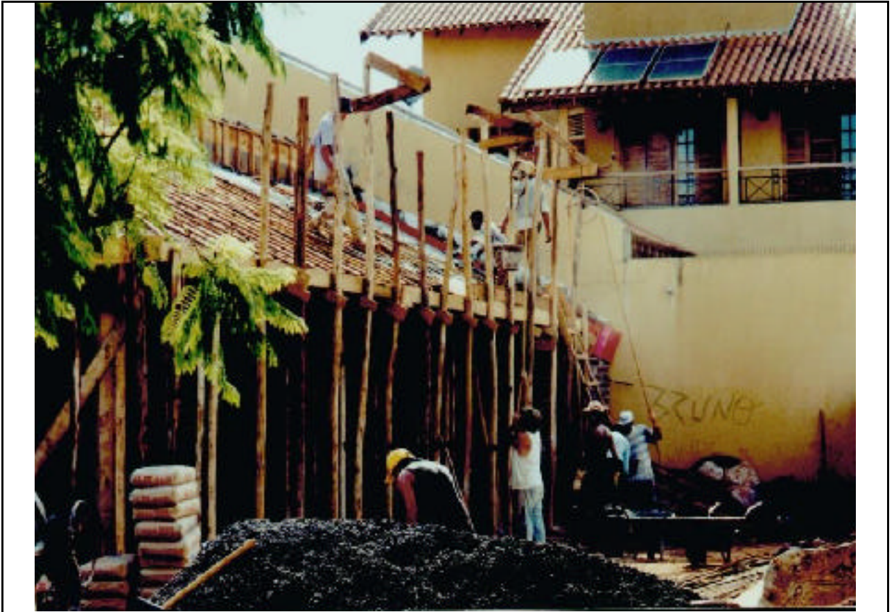
FIGURA 14 – Vista da concretagem da laje e vigas da cobertura.
