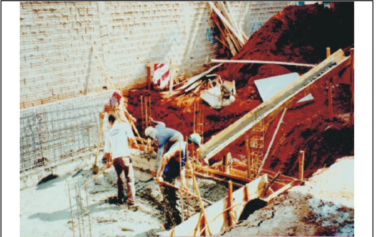
FIGURA 18 – Vista da concretagem da piscina.
