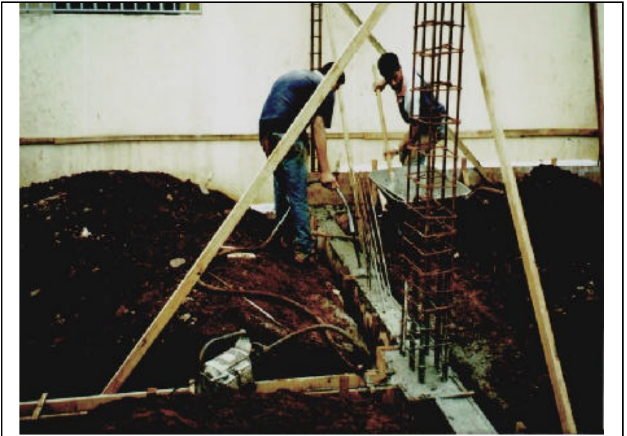
FIGURA 10 – Vista da concretagem das vigas baldrame.
