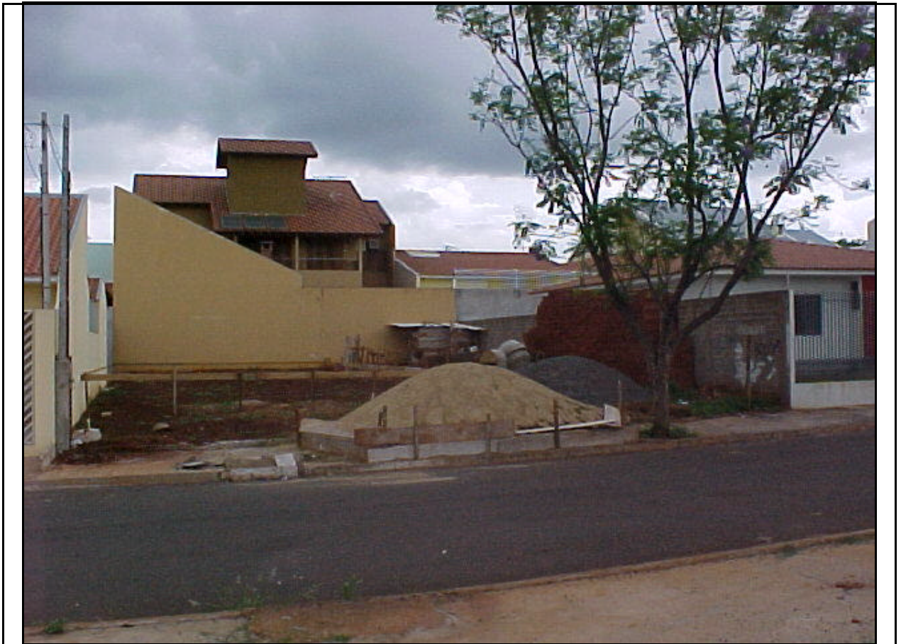
FIGURA 6 – Vista do canteiro de obra implantado no terreno.
