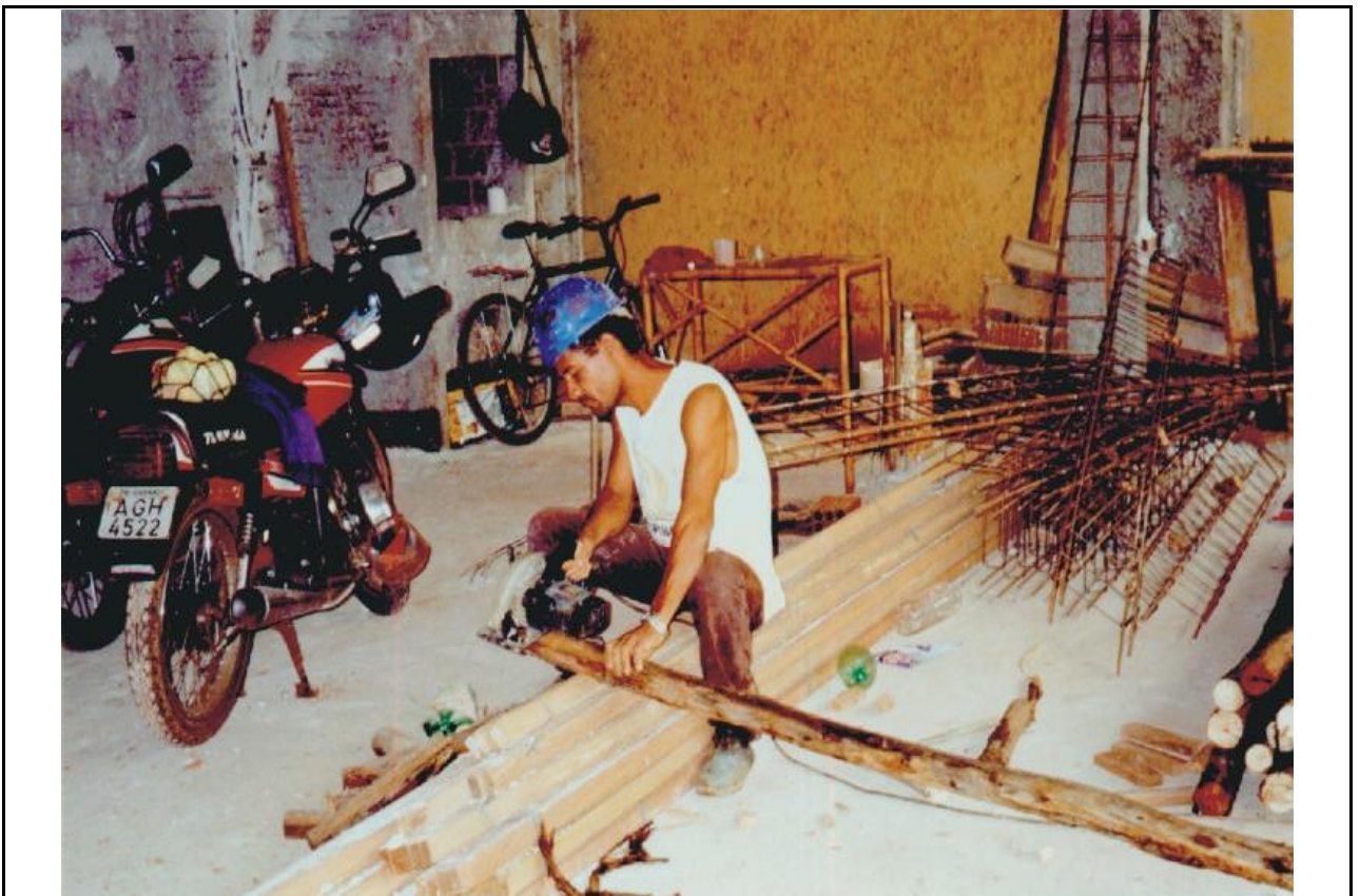
FIGURA 21 – Vista dos cortes das formas de madeira com a serra elétrica manual.
