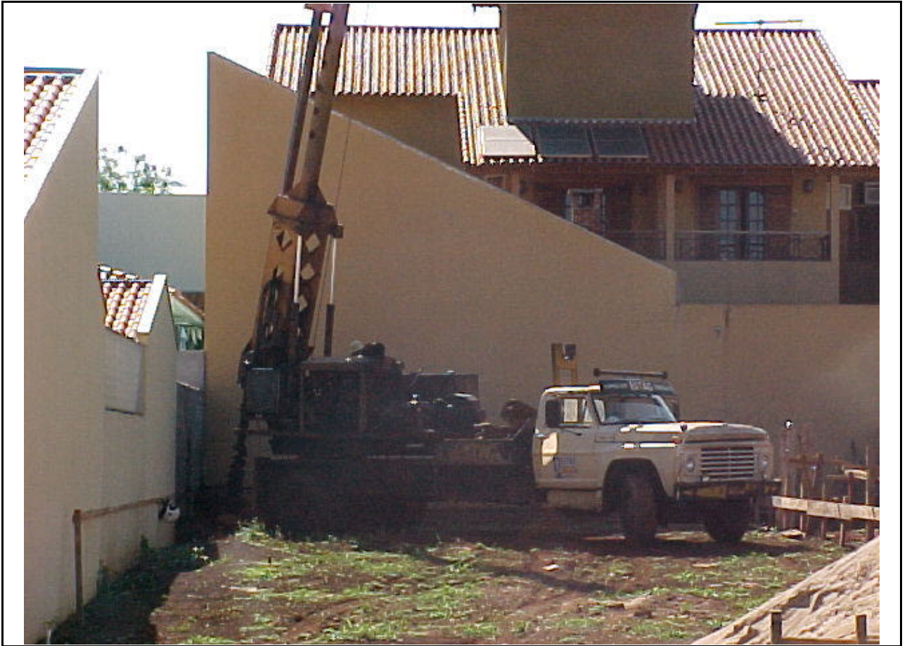
FIGURA 8 – Vista da execução do estaqueamento executado pelo caminhão-perfuratriz.
