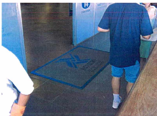
Figura 5.16 - Tapetes salientes, desprovidos de cor contrastante são barreiras para pessoas com baixa visão.
