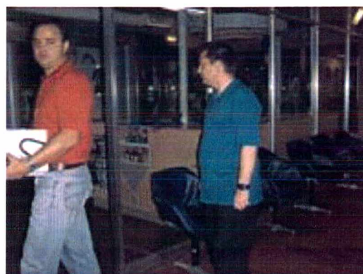
Figura 5.19 - Áreas transparentes: vidros sem faixas contrastantes são barreiras para pessoas com baixa visão.
