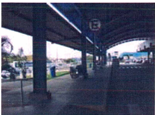
Figura 4.2 - Área de Circulação de Entrada do Prédio:
