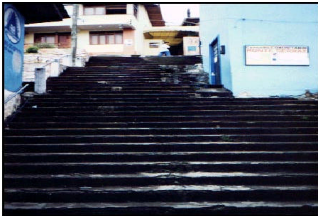
Foto 2 - Acesso ao CS Mont Serrat
